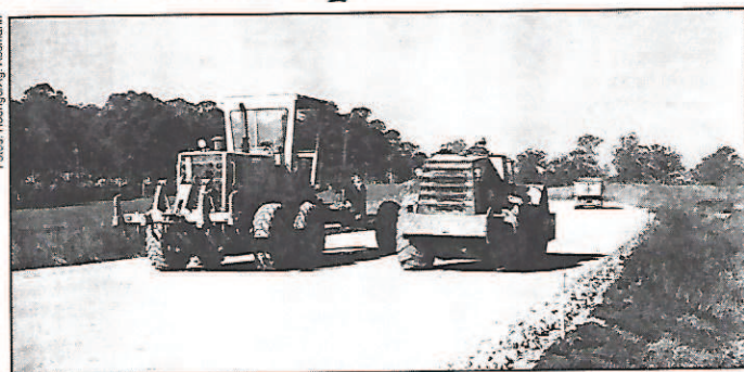
Previsão é de que as obras de pavimentação sejam concluídas até a tarde de hoje
