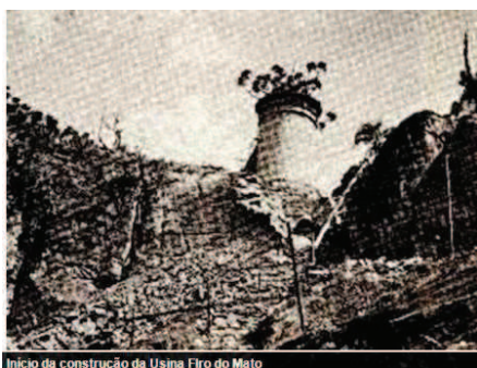
Início da construção da Usina Flor do Mato
