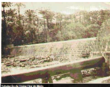
Tubulação da Usina Flor do Mato
