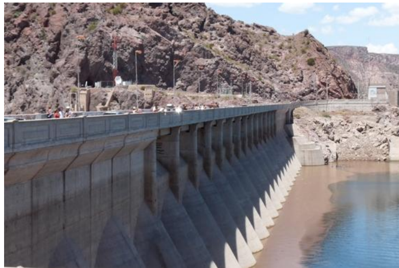
Figura 4 – Barragem de contrafortes de Valle Grande, no rio Atuel, San Rafael, Argentina Fonte: Do autor
