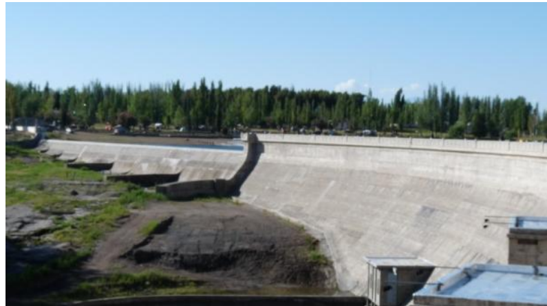
Figura 6 – Barragem de arco-gravidade de Nihuil I, no rio Atuel, San Rafael, Argentina Fonte: Do autor
