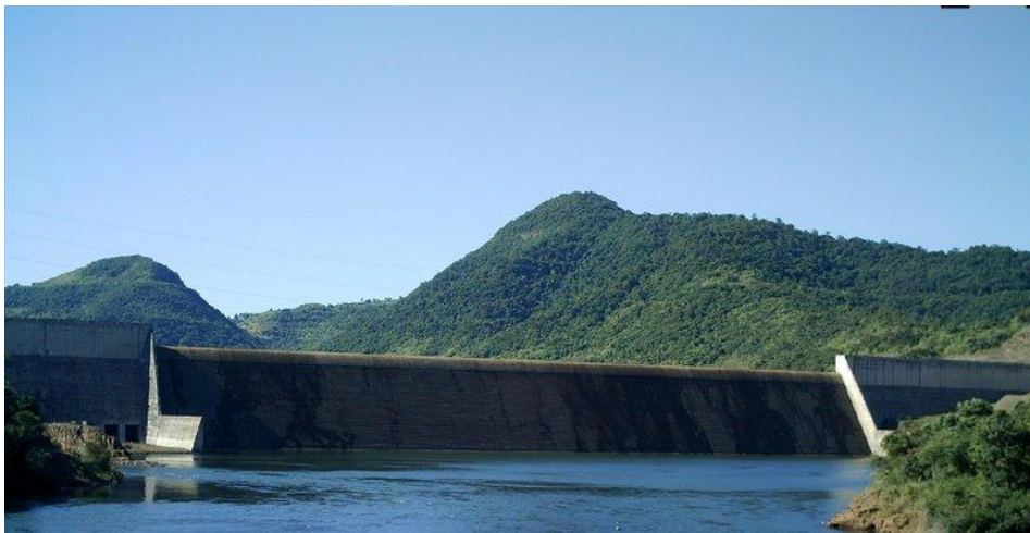
Figura 2– Barragem de gravidade de Dona Francisca, no rio Jacuí, Dona Francisca, Rio Grande do Sul Fonte: Do autor
