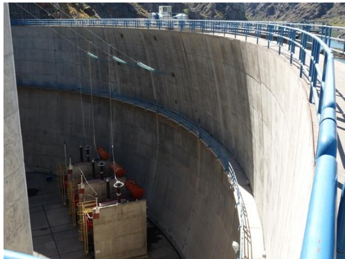
Figura 8 – Barragem de abóboda de Tigre, no rio Diamante, San Rafael, Argentina Fonte: Do autor
