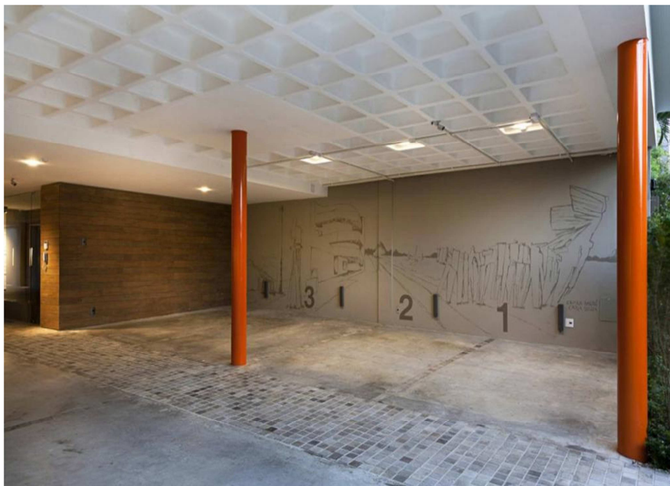
Figura 12 – Aspecto final da laje lisa nervurada acabada
