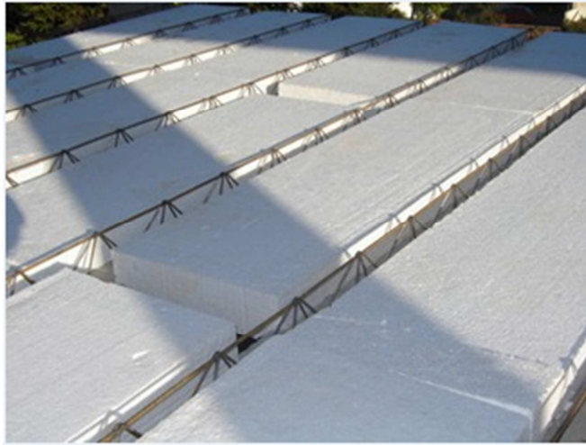
Figura 7 – Laje pré-moldada treliçada unidirecional
