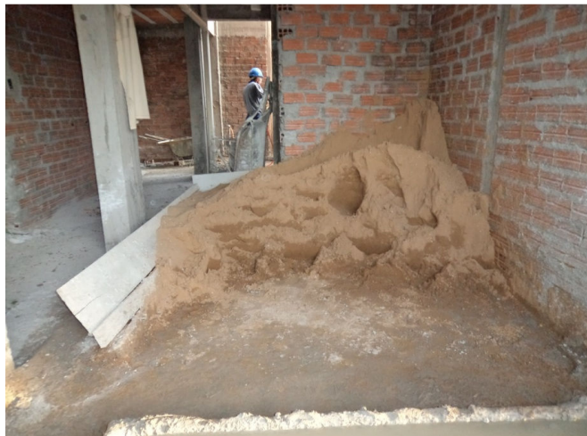
Figura 17 - Estoque de areia na obra
