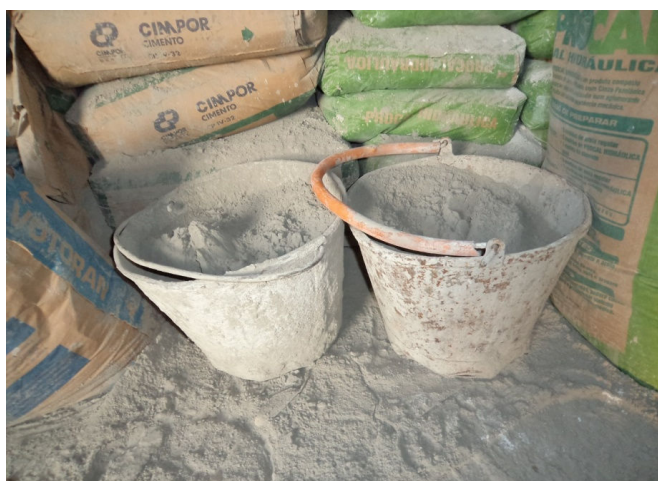
Figura 19 - Baldes para dosagem do cimento
