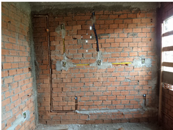
Figura 55 - Parede com canaletas abertas no sentido horizontal e vertical para instalações elétricas e hidráulicas
