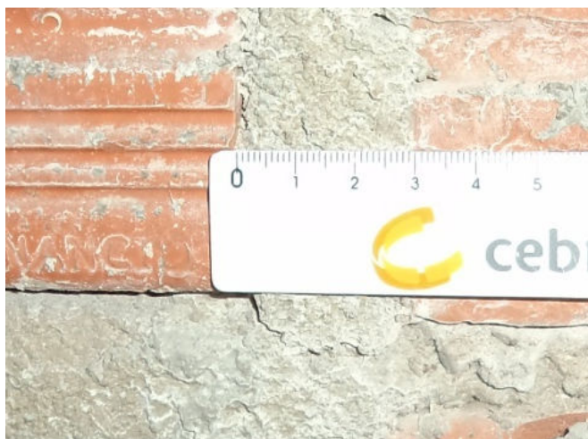
Figura 41 - Espessura da junta de assentamento vertical
