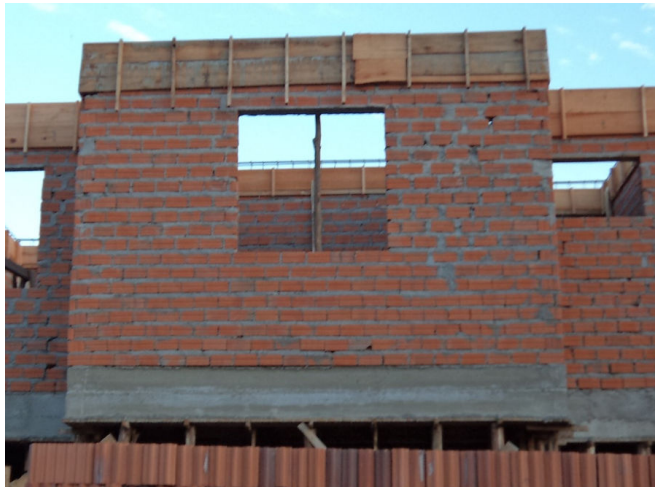
Figura 46 - Formas laterais das vigas construídas logo após a desforma dos pilares
