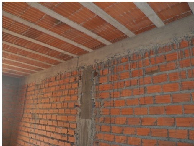
Figura 50 - Viga desformada e laje com as escoras retiradas
