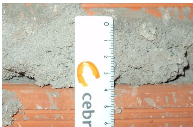
Figura 39 - Espessura da junta de assentamento horizontal
