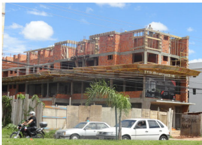
Figura 13 – Edifício em construção em Santa Maria
