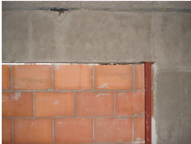
Figura 5- Espaço entre a alvenaria e a estrutura para encunhamento com argamassa expansiva
