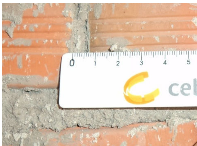
Figura 40 - Espessura da junta de assentamento vertical
