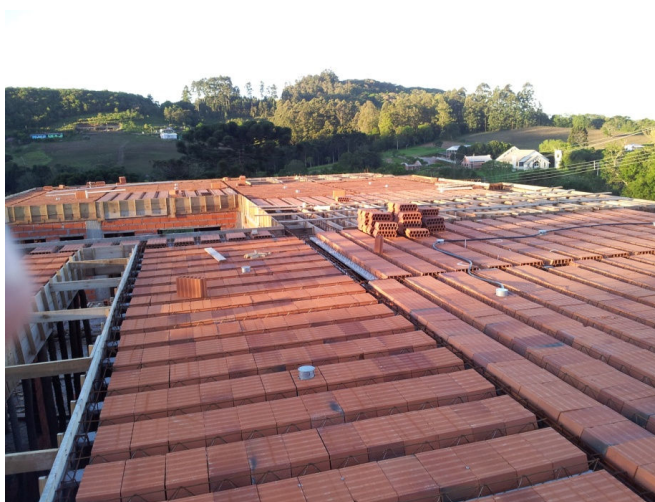
Figura 48 – Laje treliçada montada
