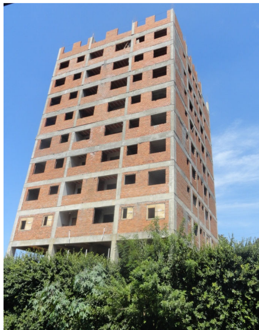
Figura 10 – Edifício em construção com mais de 8 pavimentos no município de São Leopoldo
