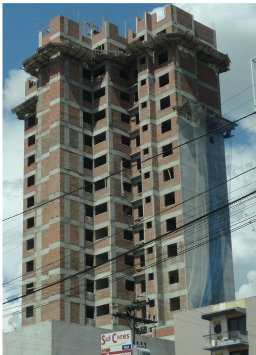
Figura 12 – Edifício no município de Passo Fundo com mais de 13 pavimentos sendo construído
