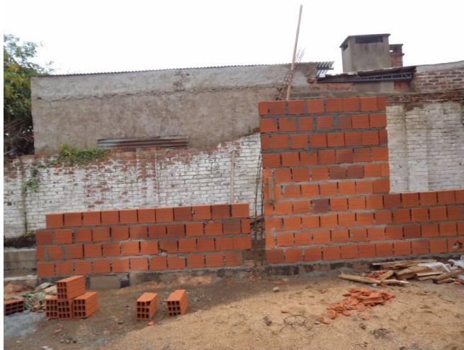
Figura 37 – Alvenaria sendo construída já com as armaduras dos pilares concluídas
