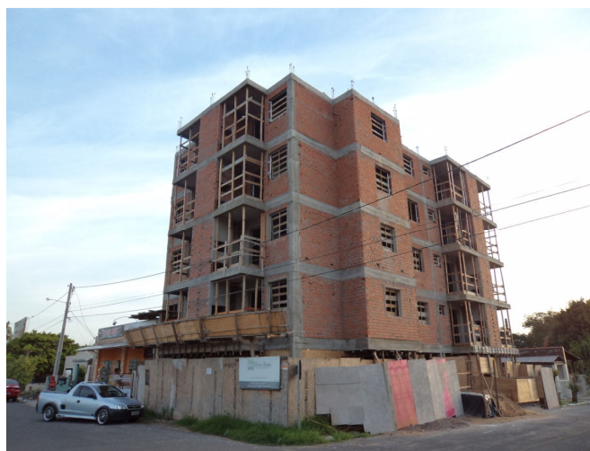
Figura 14 - Vista da obra visitada
