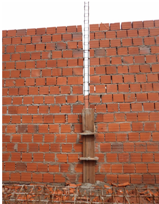
Figura 42 - Forma do pilar com os painéis laterais e ferragens erguida até a altura da alvenaria
