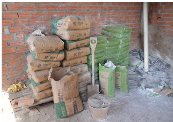
Figura 18 - Cimento e cal armazenados na obra
