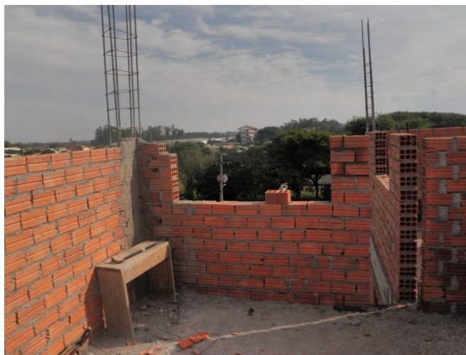
Figura 43 - A esquerda, um pilar concretado até a altura de 1,40 metros e a direita, um espaço para um pilar com esperas de ancoragem
