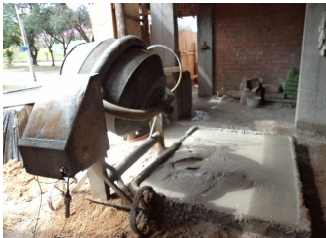
Figura 16 - Central de produção da argamassa
