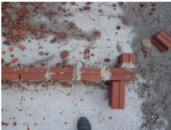
Figura 35 – Primeira fiada de alvenaria
