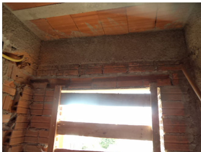
Figura 26 - Abertura de canaleta onde deveria haver uma verga
