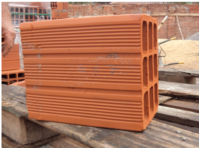
Figura 32 – Bloco cerâmico 9 furos de vedação utilizado no empreendimento
