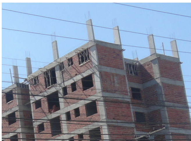
Figura 45 – Pilares construídos anteriormente à alvenaria
