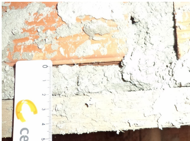
Figura 52 - Verga com espessura de 2,0 cm
