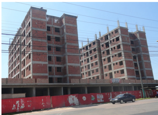
Figura 11 – Condomínio com mais de duas torres em construção em São Leopoldo
