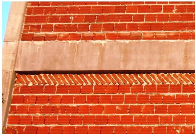
Figura 3 - Encunhamento com tijolos maciços inclinados
