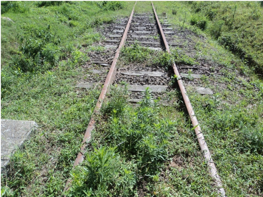
Figura 24 - Vegetação sobre a ferrovia dentro do Entroncamento Rodo-Ferro-Hidroviário de Estrela
