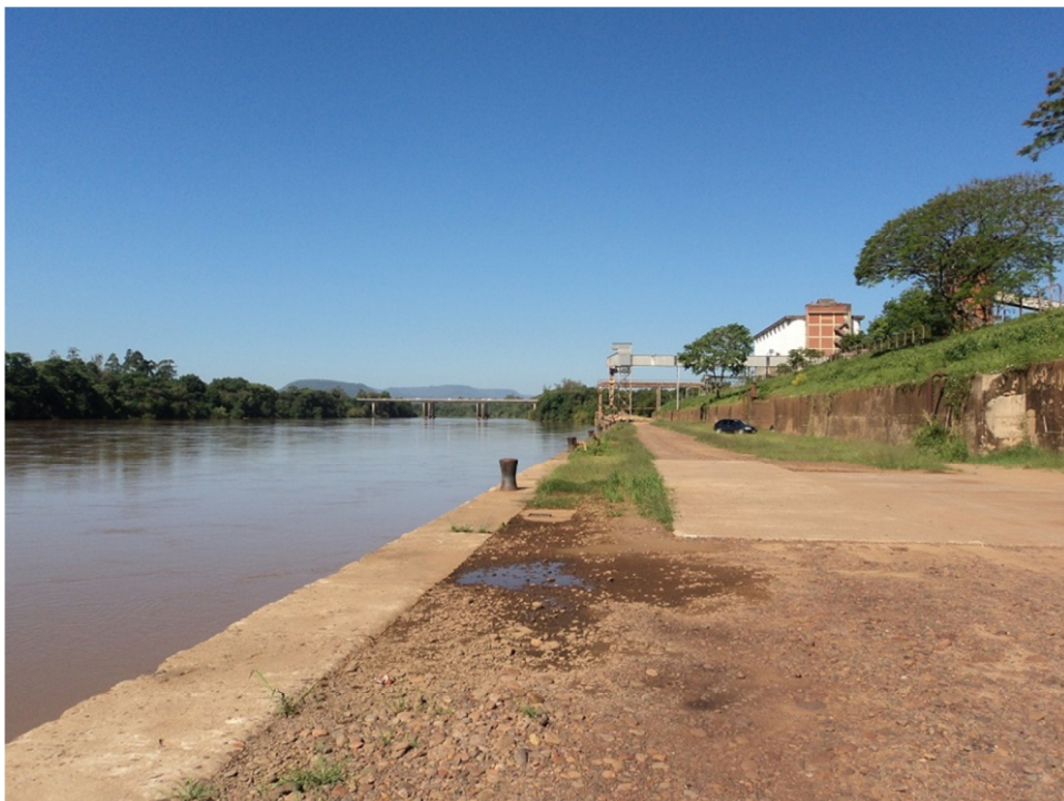
Figura 18 - Berços de atracação do Porto Fluvial de Estrela
