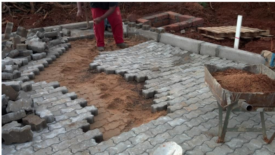
Figura 3 Detalhe para o fácil acesso as camadas inferiores do pavimento.
