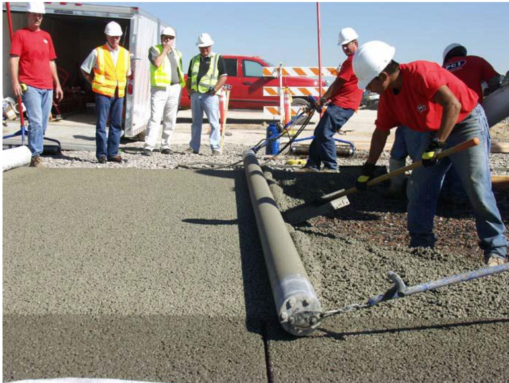
Figura 7 Compactação do concreto permeável utilizando rolo.
