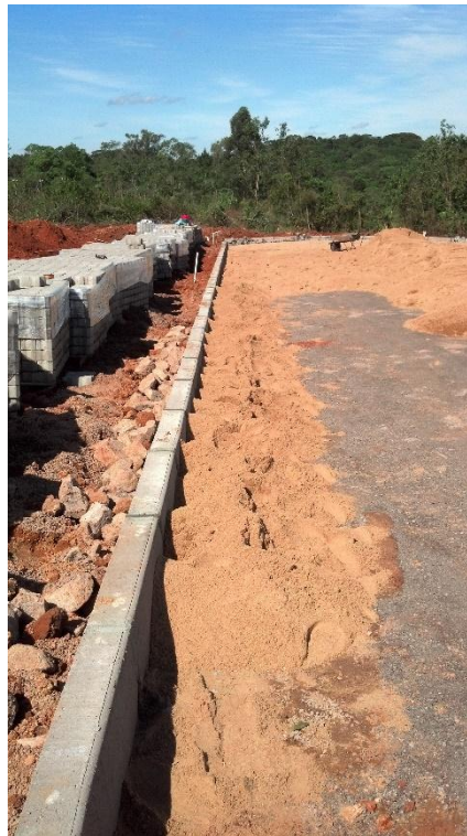
Figura 4 Colocação das restrições laterais antes do assentamento do bloco.
