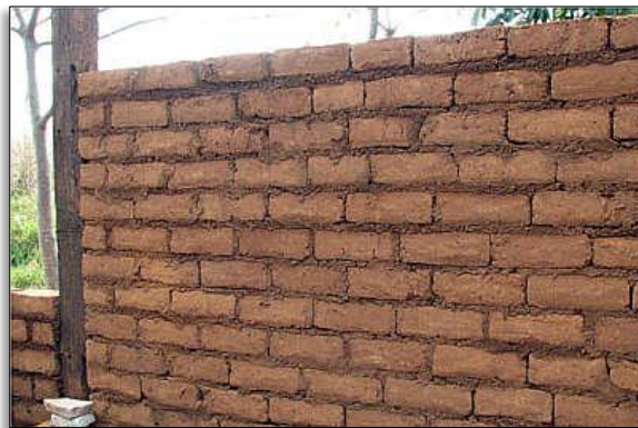
Figura 3 - Parede de adobes e juntas de argila
