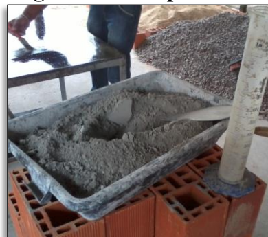
Figura 11- Preparo da argamassa de capeamento
