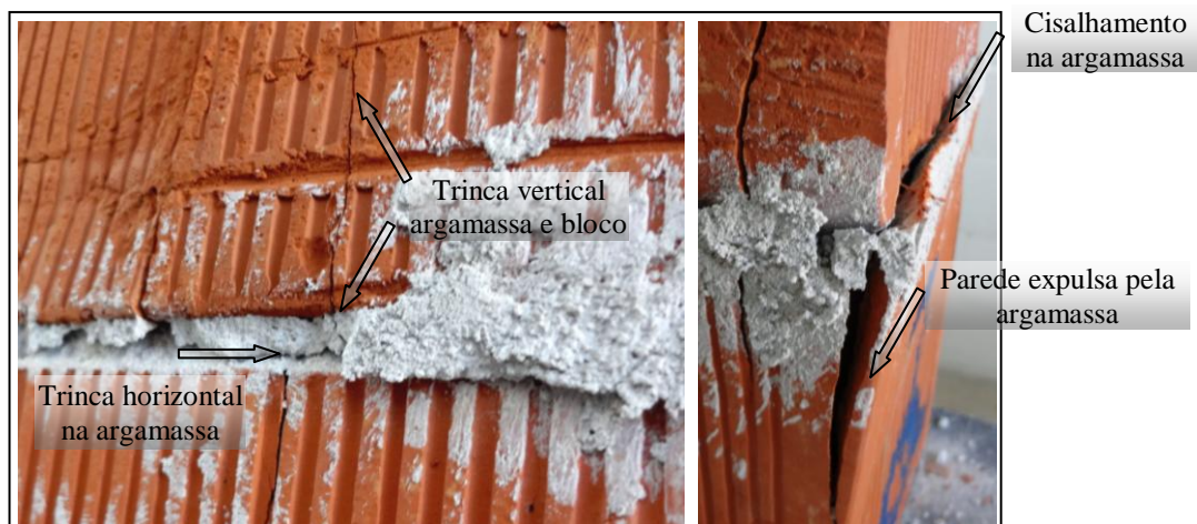
Figura 30 - Rompimentos típicos da junta Tipo 2
