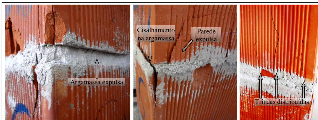
Figura 38 - Rompimentos típicos da junta Tipo 6
