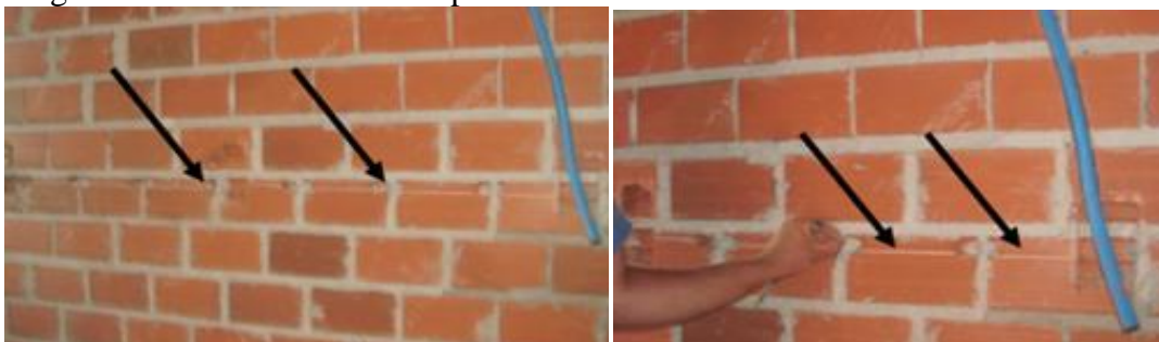
Figura 29: Corte horizontal na parede da obra 2.
