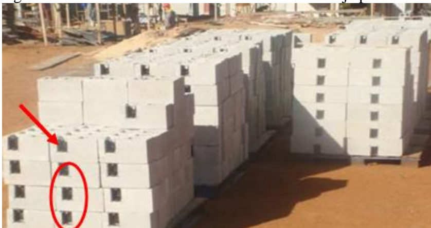
Figura 10 : Blocos de concreto com caixas elétricas já prontas.
