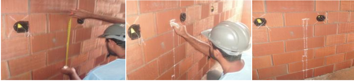
Figura 55: Marcação das paredes nos pontos hidráulicos na obra 5.
