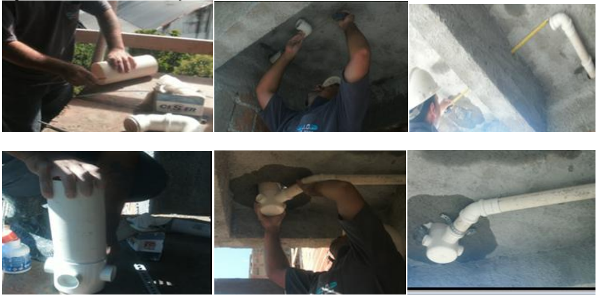
Figura 51: Passos na instalação cloacal da sacada na obra 3.
