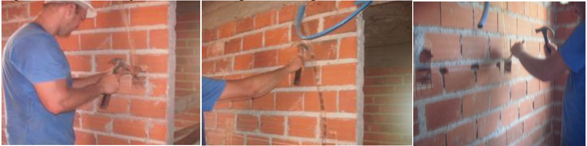
Figura 27: Visualização dos cortes na parede dos pontos elétricos da obra 2.
