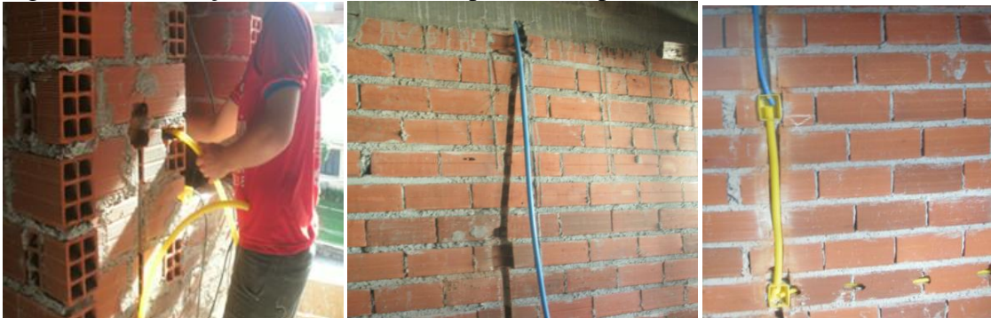
Figura 28: Colocação dos eletrodutos na parede nos pontos elétricos da obra 2.
