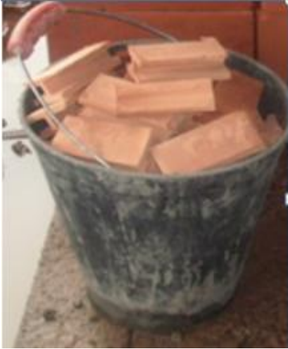
Figura 42: Desperdício de bloco cerâmico na obra 4.
