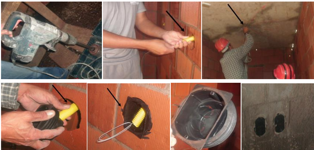
Figura 44: Visualização de algumas etapas construtivas do sistema elétrico da obra 5.
