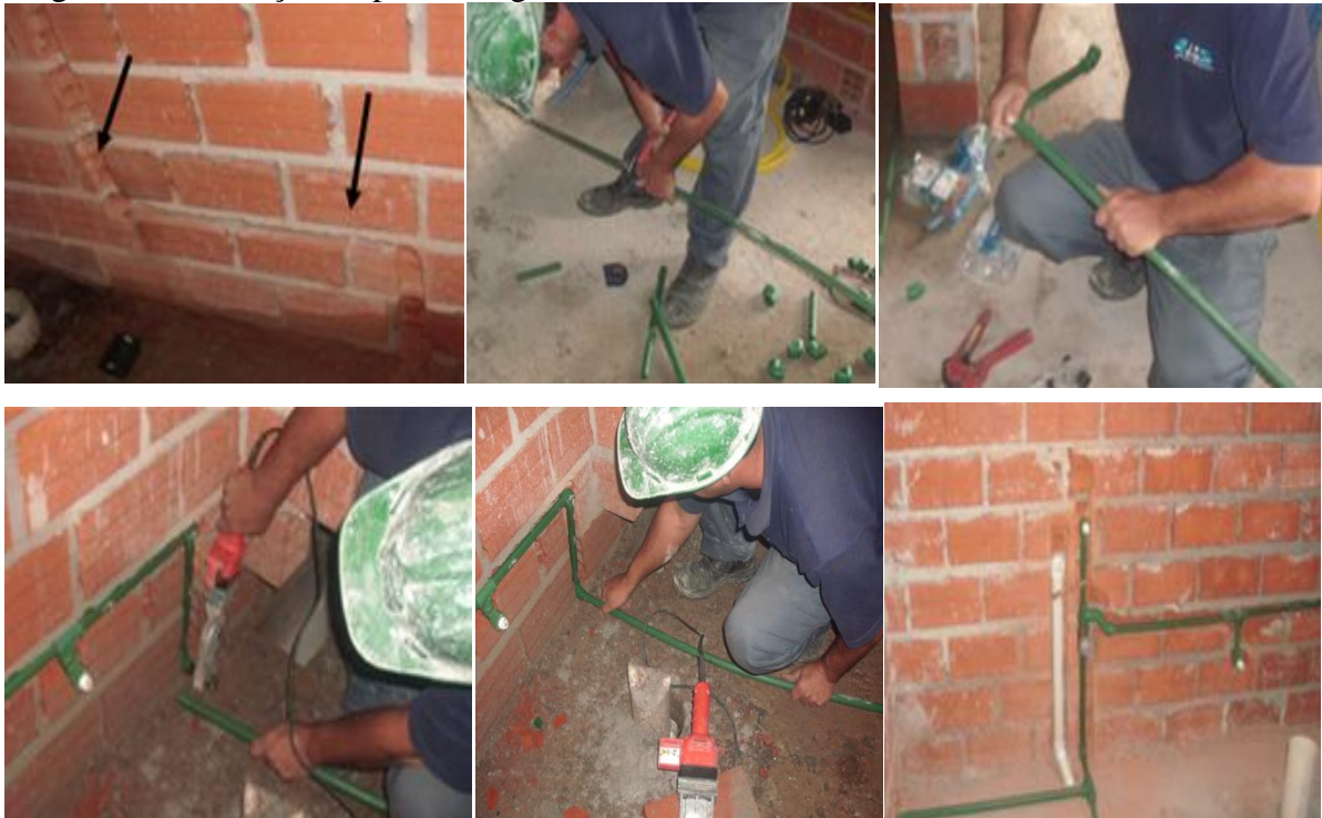
Figura 52: Instalação da parte de água na obra 3.
