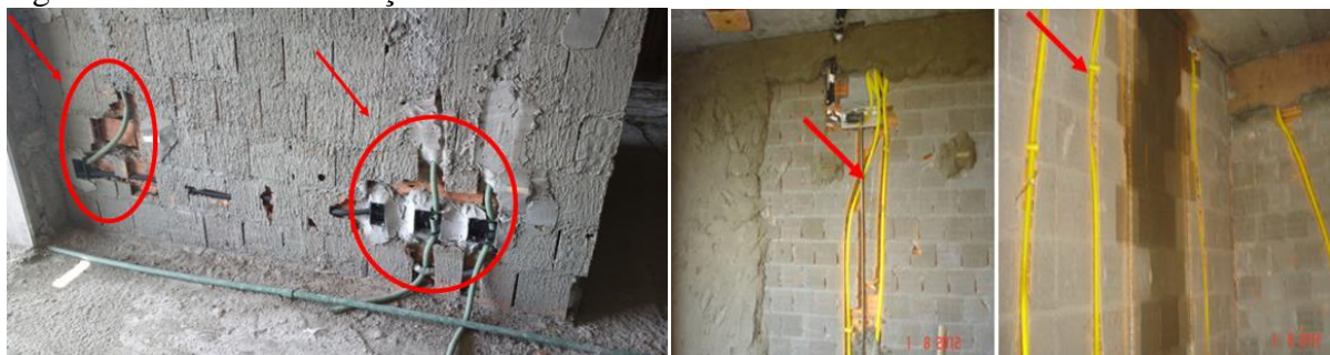
Figura 5: Pontos de instalações elétricas no sistema tradicional.
