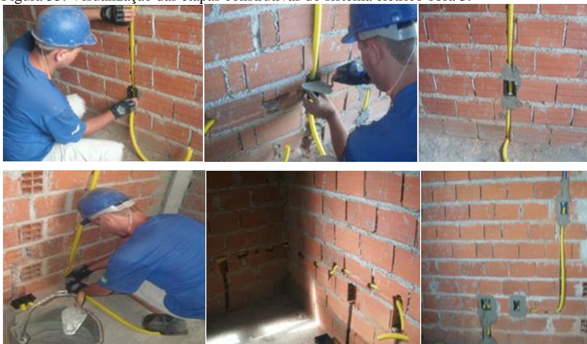
Figura 33: Visualização das etapas construtivas do sistema elétrico obra 3.
