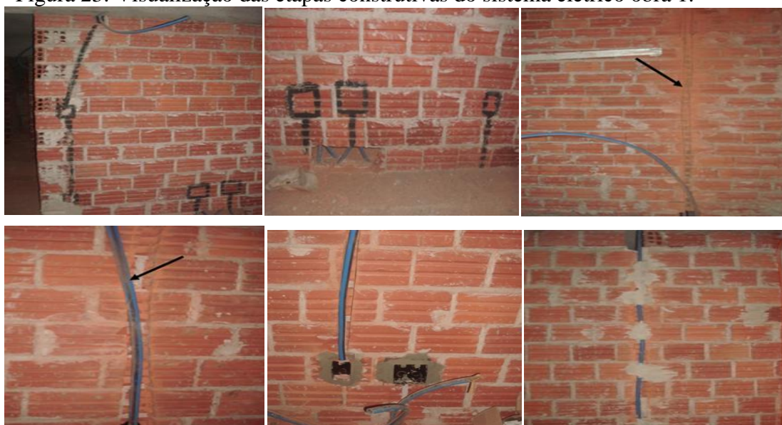
Figura 23: Visualização das etapas construtivas do sistema elétrico obra 1.
