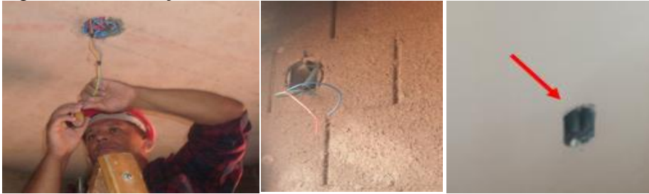
Figura 45: Colocação de fios na obra 5.
