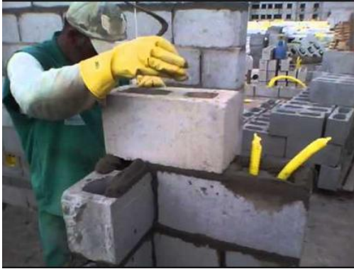
Figura 11: Tubulações elétricas já nos blocos de concreto.
