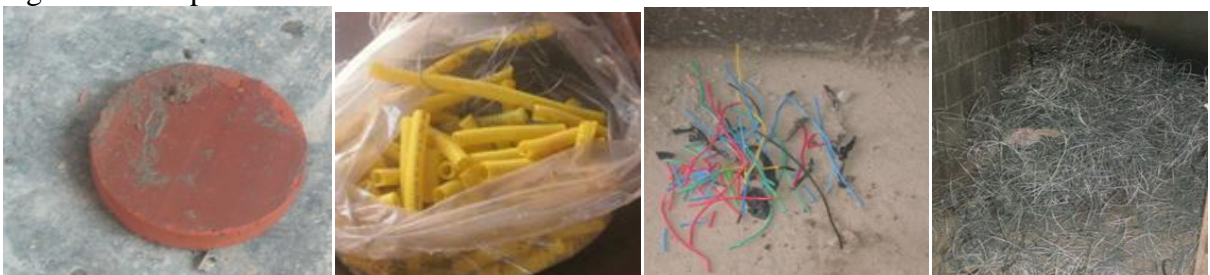
Figura 46: Desperdícios na obra 5.
