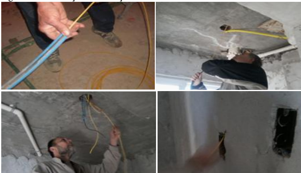
Figura 24: Colocação de enfição na obra 1.
