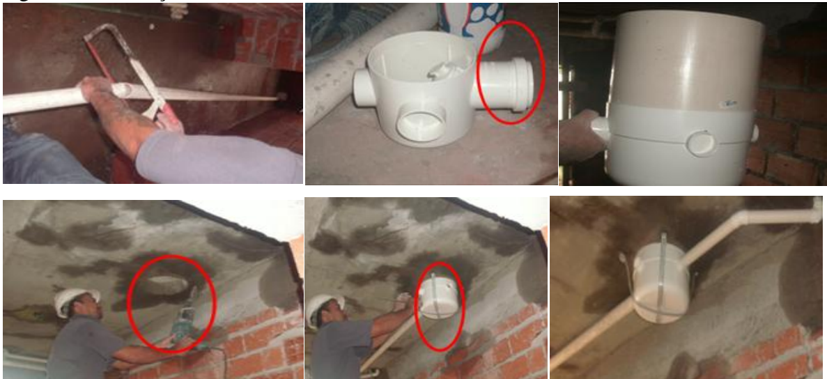
Figura 50: Instalação cloacal na cozinha na obra 3.
