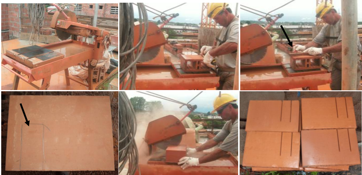
Figura 38: Visualização da marcação e corte dos pontos elétricos da obra4.
