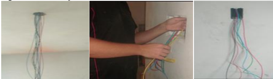
Figura 34: Instalação dos fios na obra 3.
