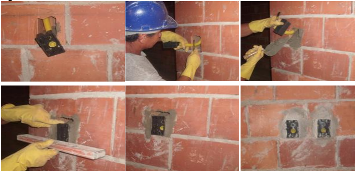
Figura 40: Fechamento das caixinhas com massa da obra 4.
