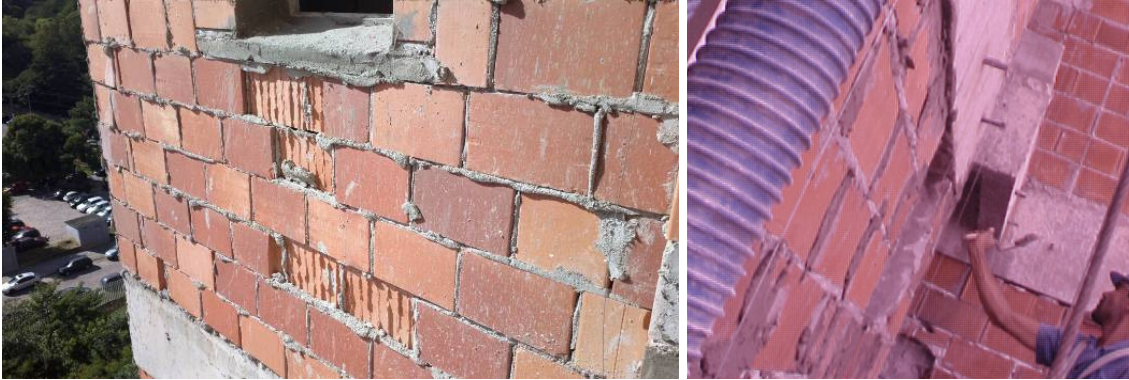
Figura 04 – Correção dos pontos falhos do plano a ser revestido.
