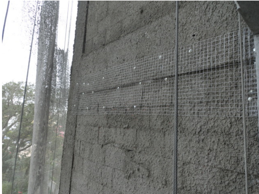
Figura 13 – Interface estrutura/alvenaria de vedação reforçada com tela metálica.
