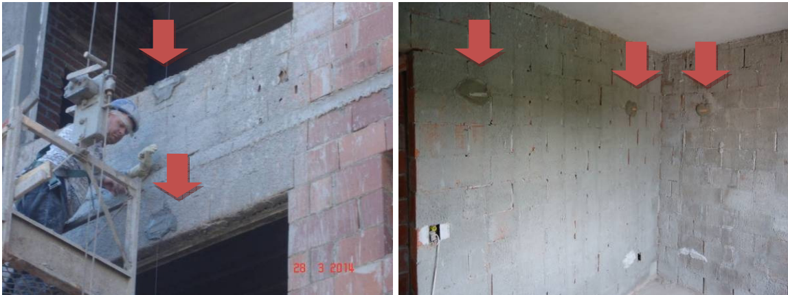
Figura 07 – Execução do taliscamento (externo e interno).
