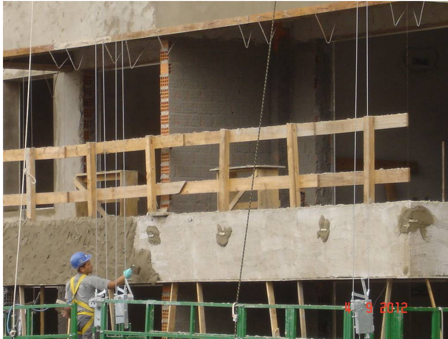
Figura 08 – Execução do emboço após as mestras adquirirem resistência.
