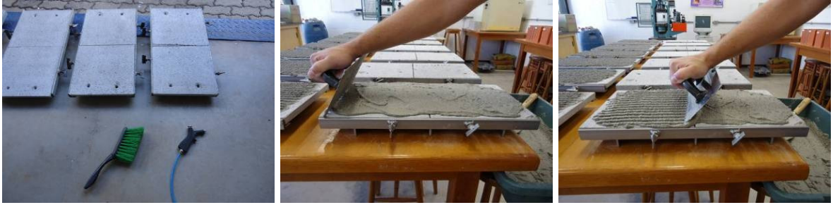
Figura 56 – Limpeza das placas e aplicação do chapisco.
