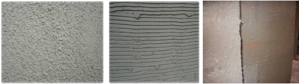
Figura 05 – Aplicação de chapisco tradicional, industrial e rolado.
