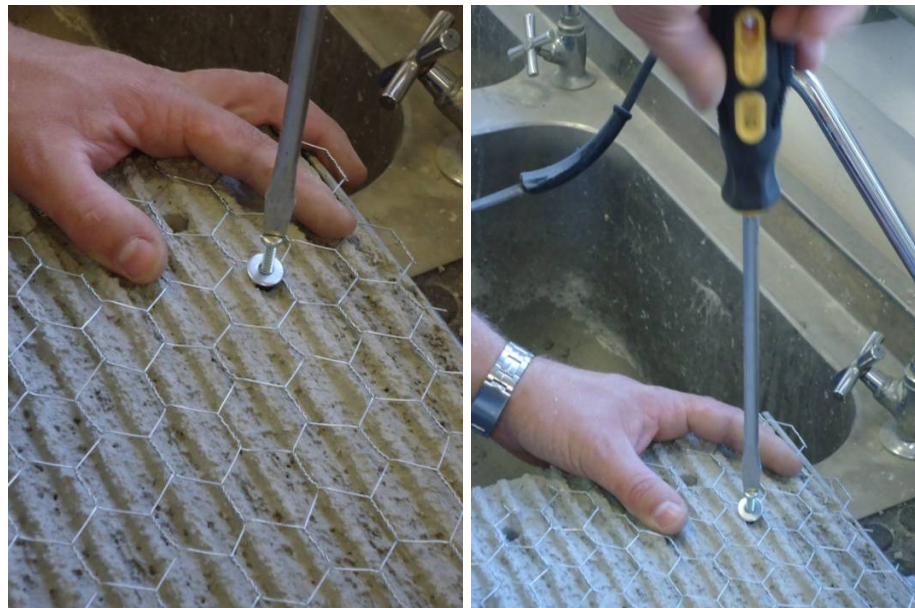
Figura 57 – Fixação das telas nas placas.
