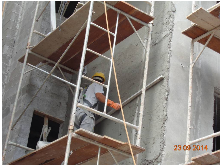
Figura 10 – Sarrafeamento executado com régua de alumínio apoiado nas mestras.
