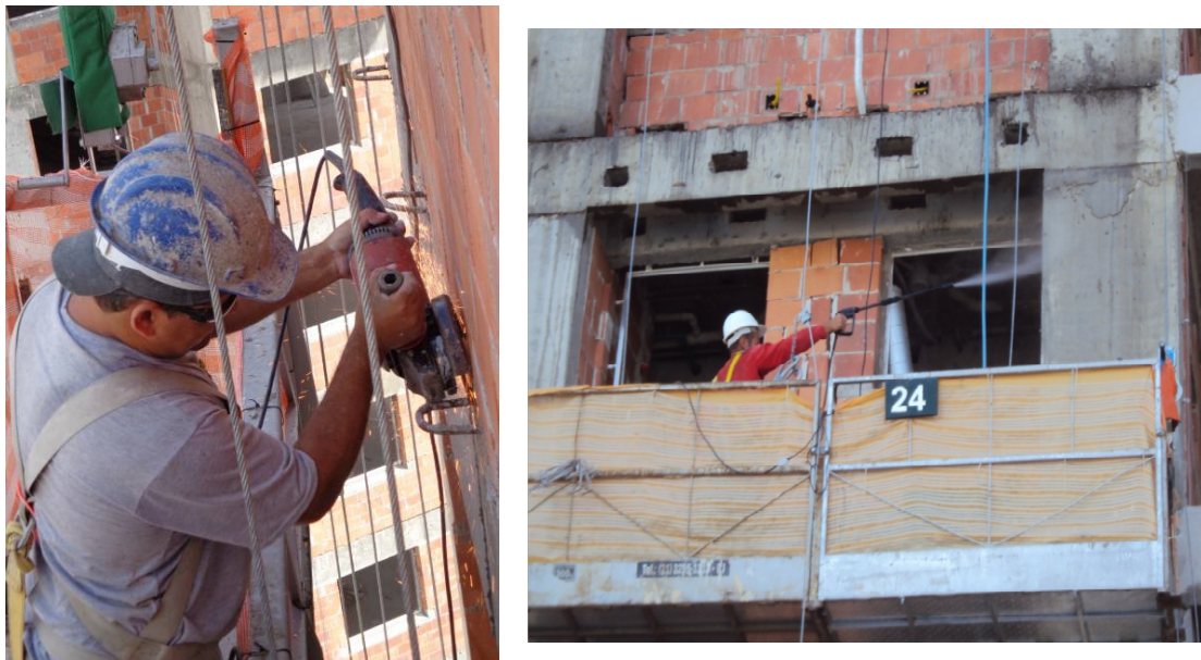
Figura 03 – Retirada de saliências e limpeza da superfície.
