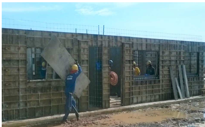
Figura 31: Montagem do sistema de fôrmas.
