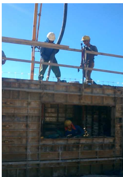
Figura 35: Concreto sendo lançado nas fôrmas.
