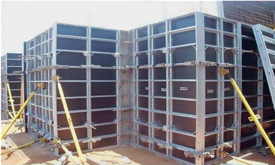
Figura 3: Fôrma com estrutura metálica com painéis de compensado.
