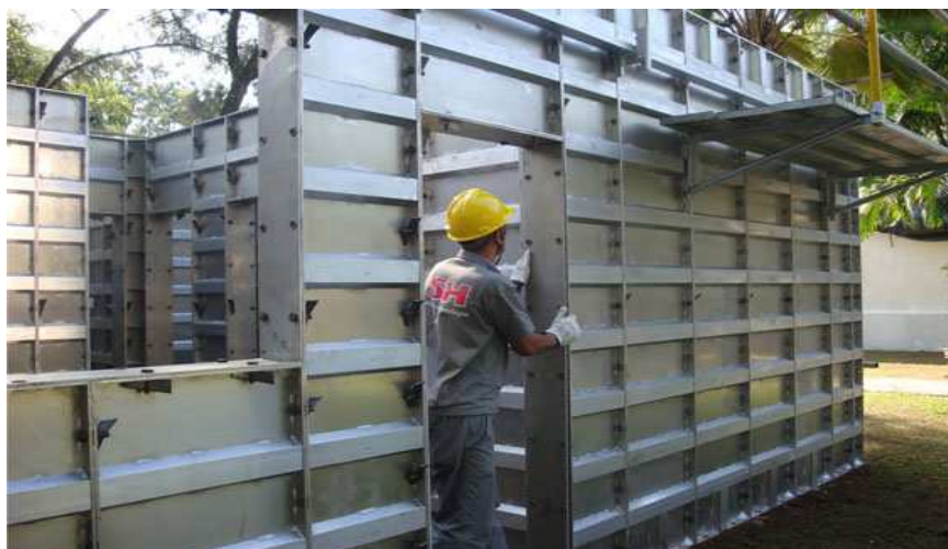
Figura 14: Montagem de fôrmas.
