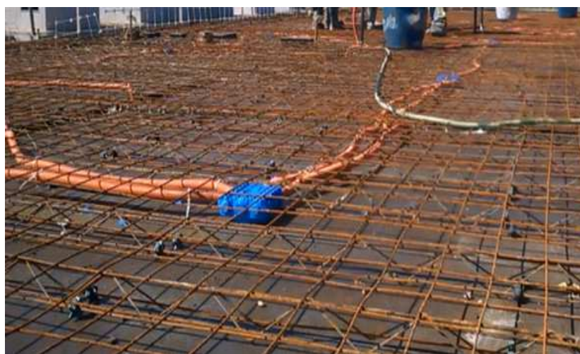
Figura 32: Armaduras e instalações posicionadas nas lajes.
