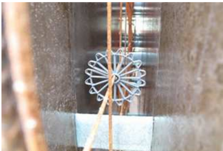
Figura 10: Espaçador fixado à armadura.
