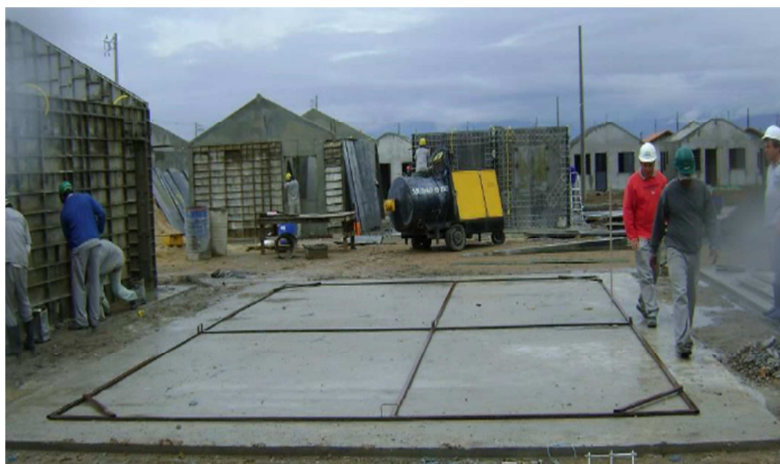
Figura 8: Fundação do tipo radier.
