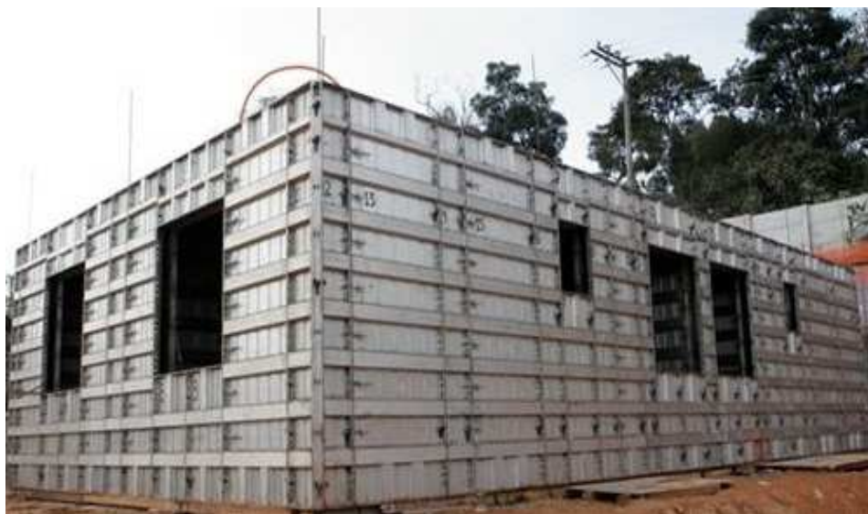
Figura 2: Fôrma metálica.
