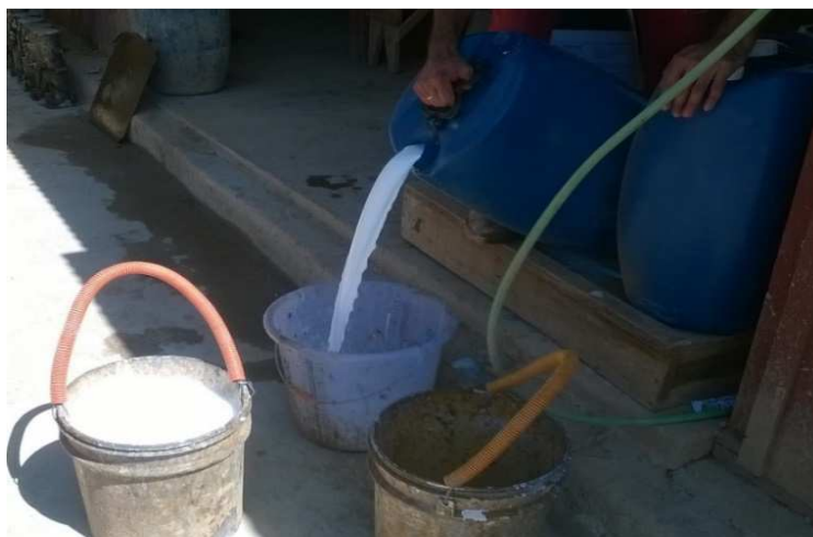
Figura 34: Preparo do incorporador de ar para adicionar ao concreto.
