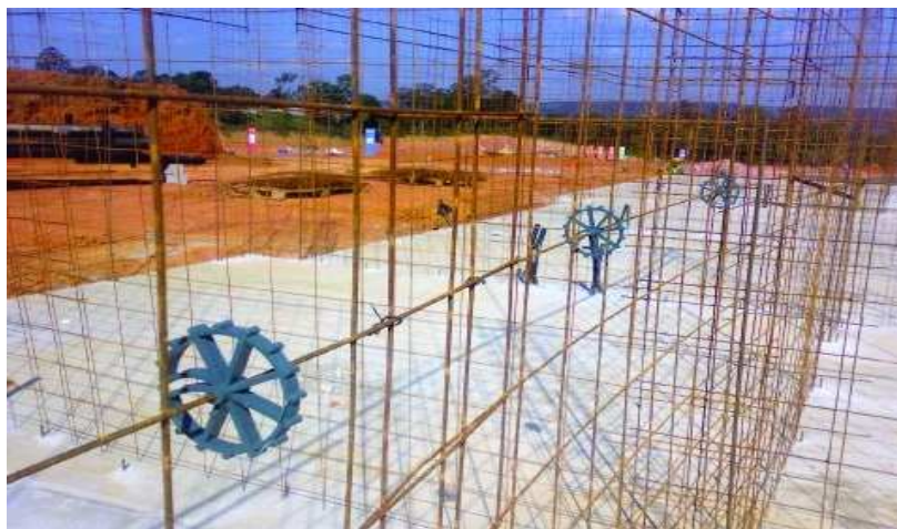
Figura 9: Armaduras prontas para colocar fôrmas.
