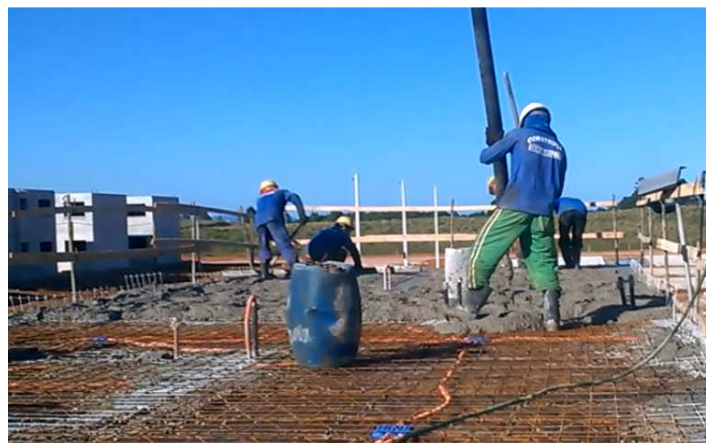
Figura 37: Lançamento, espalhamento e nivelamento do concreto em lajes.
