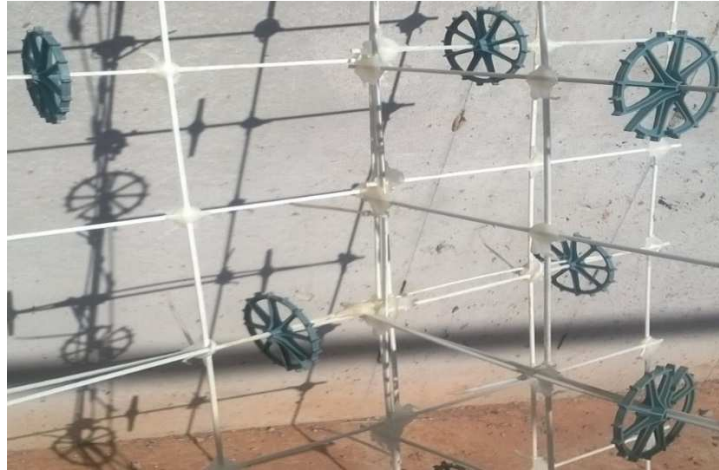
Figura 30: Espaçadores posicionados nas armaduras.
