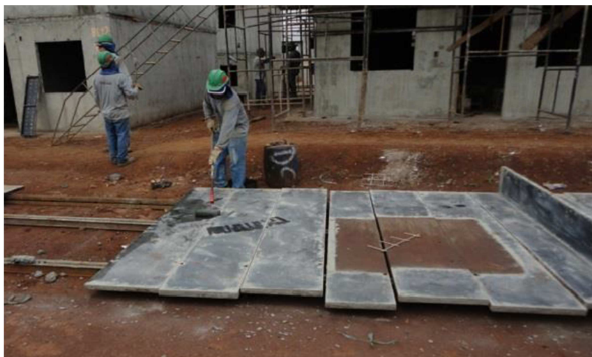
Figura 6: Aplicação de desmoldante em fôrmas.
