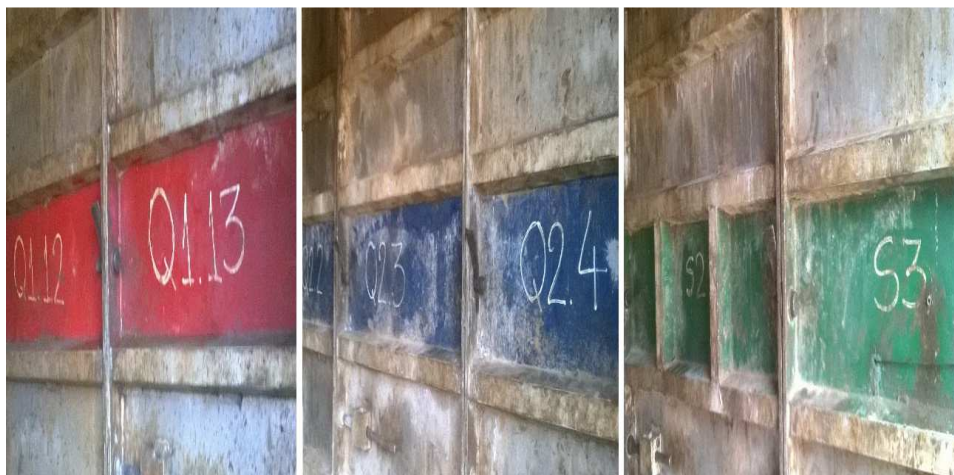
Figura 5: Determinação de posicionamento dos painéis.
