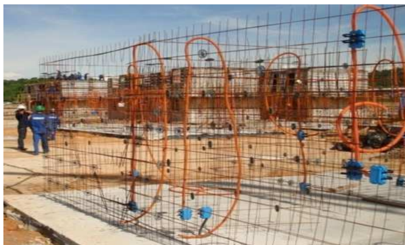
Figura 13: Instalações elétricas fixada nas armaduras.
