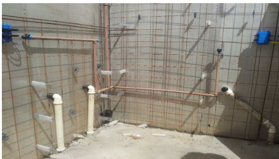
Figura 12: Tubulações fixadas nas armaduras.
