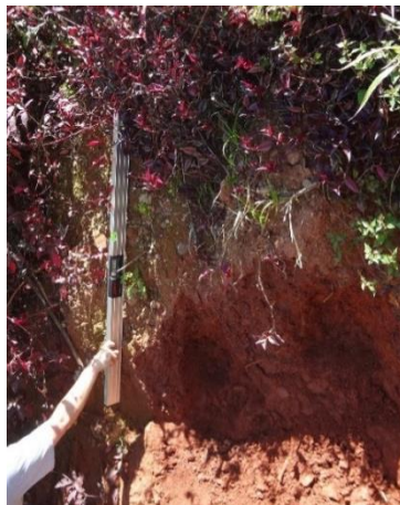
Figura 9 - Inclínômetro digital utilizado para avaliação da declividade do talude estudado
