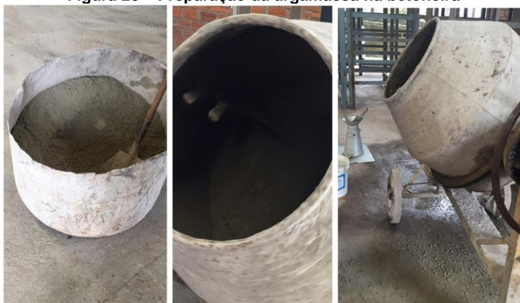
Figura 28 – Preparação da argamassa na betoneira
