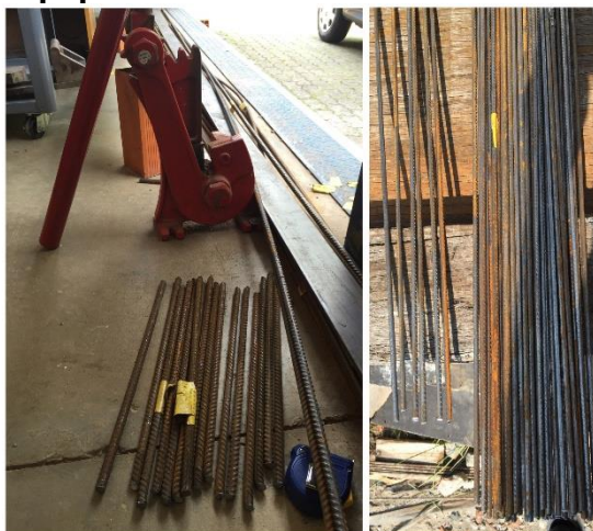
Figura 26 – Equipamento de corte e barras de aço cortadas
