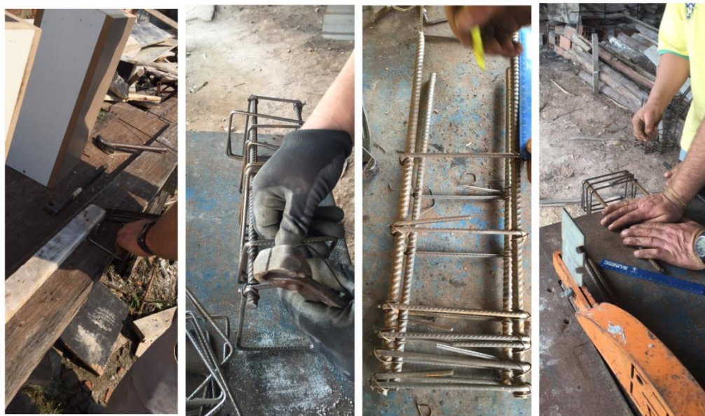
Figura 27 – Processo de montagem das armaduras
