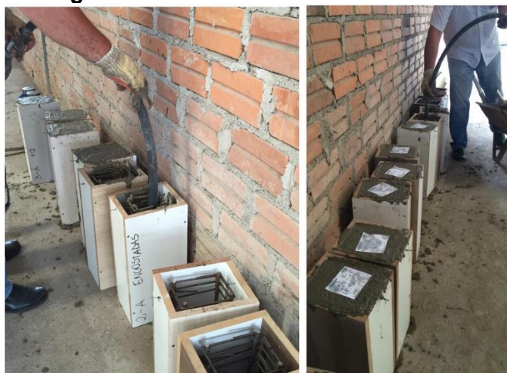
Figura 39 – Adensamento do concreto
