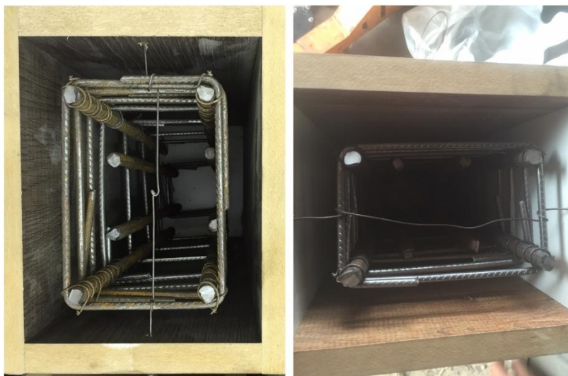
Figura 34 – Armadura posicionada com arame recozido
