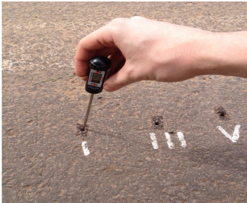
Figura 13 - Coleta da temperatura no revestimento do pavimento a 1 cm de profundidade
