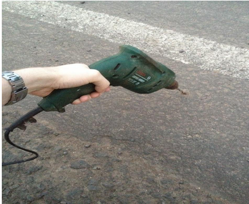
Figura 9 - Perfuração do revestimento asfáltico
