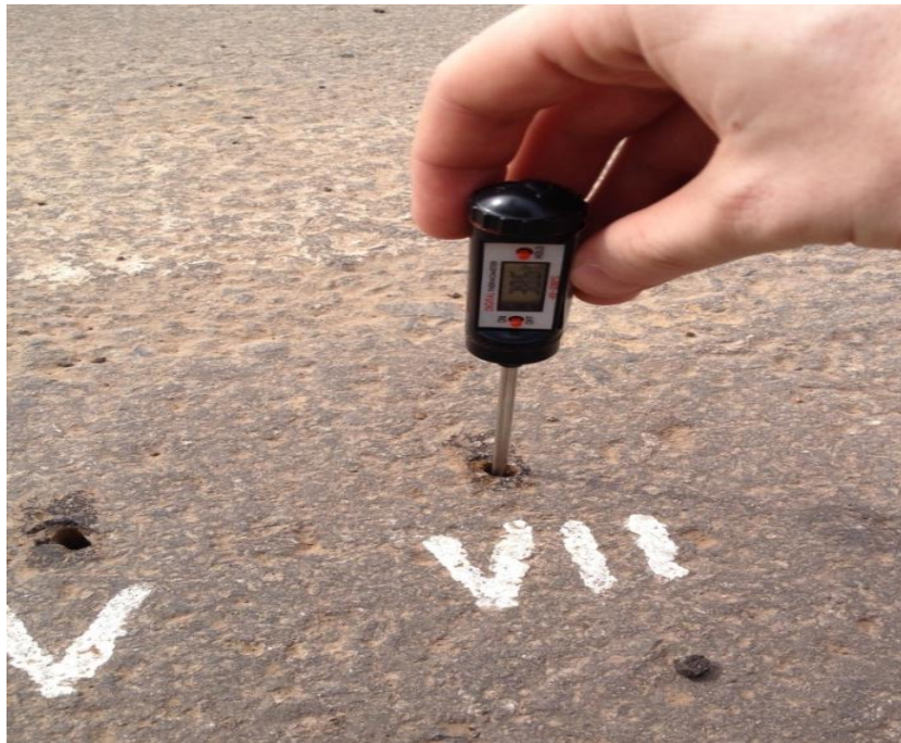
Figura 16 - Coleta da temperatura no revestimento do pavimento a 7 cm de profundidade
