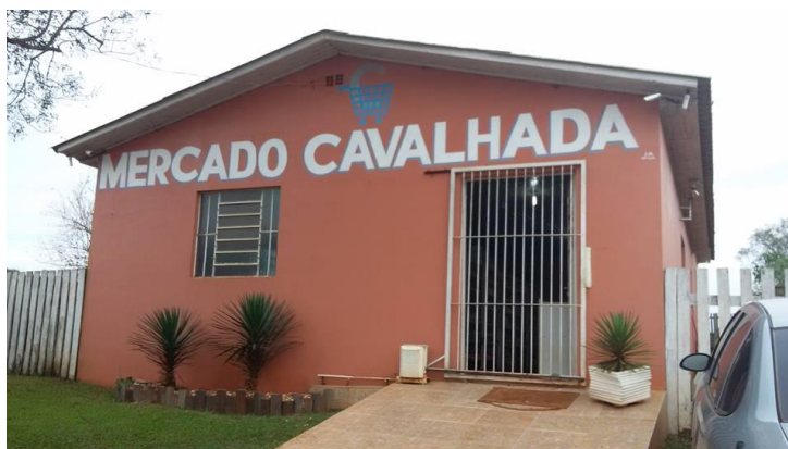
Figura 2 – Fachada da Filial da empresa Mercado Cavalhada
