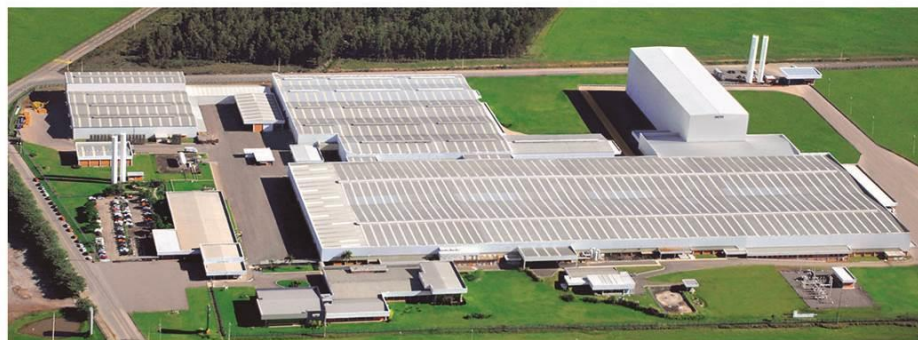
METALÚRGICA MOR MATRIZ 90.000 m 2 área construída
