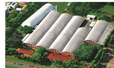
UNIDADE 3 - MOR DISTRIBUIDORA 28.000m 2 área construída
