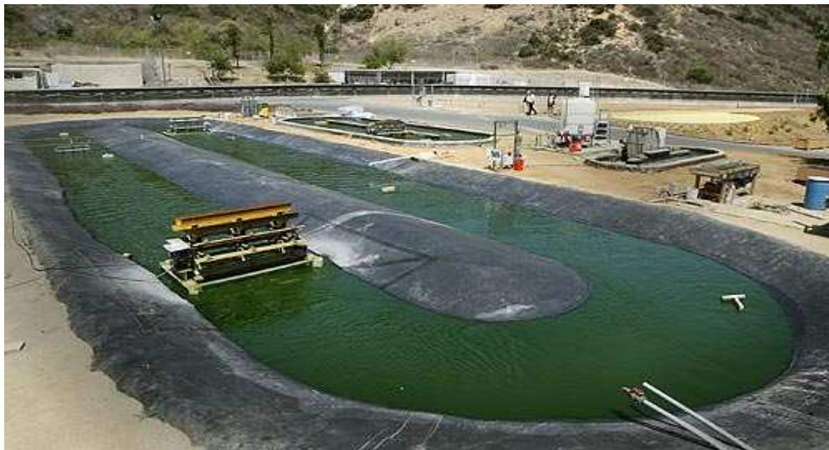
Figura 2: Tanque do tipo “ raceway pond ” típico para sistema aberto ( http://mybelojardim.com/category/aquicultura/algas-aquicultura/ ).
