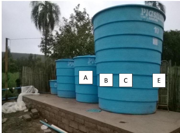
Figura 5. Sistema de irrigação com depósito de água e caixa de mistura do biofertilizante. Caixa de mistura (A), depósito de água (B, C, D, E).
