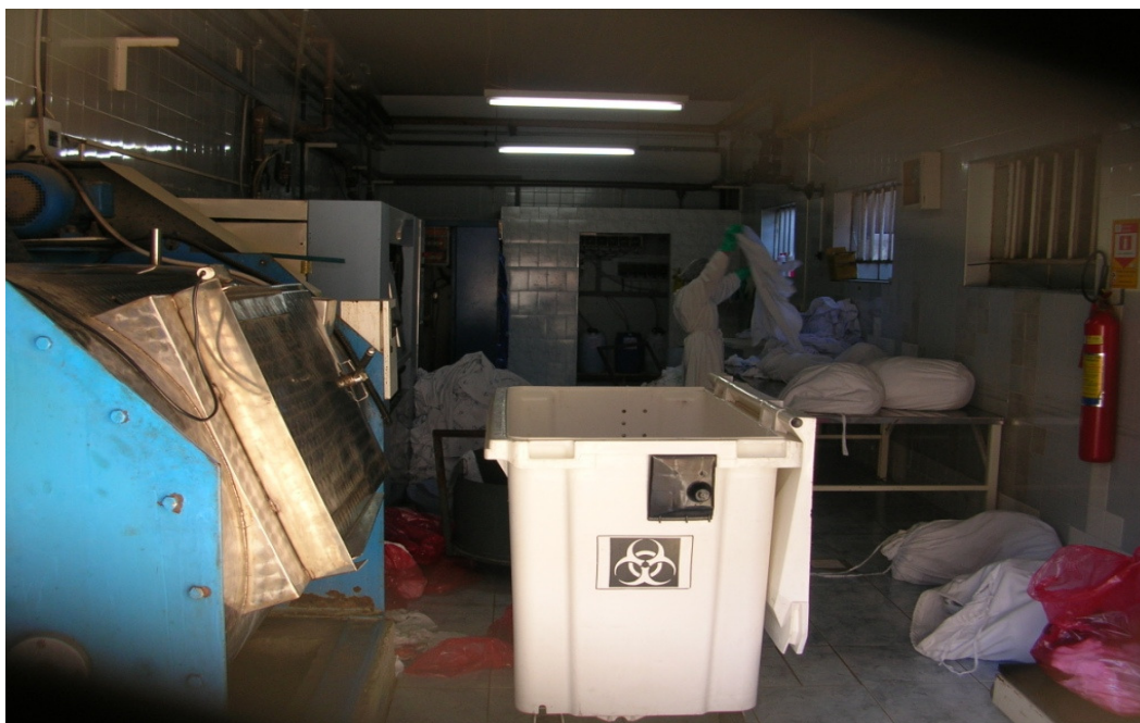
Figura 20: Vista interna da lavanderia hospitalar. Fonte: Autor
