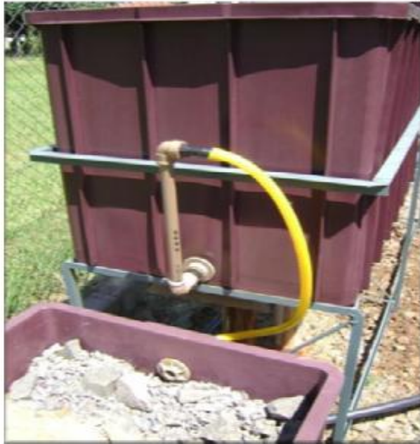
Figura 7: Foto ilustrativa destacando o cano de 0,5 polegadas e a mangueira flexível conectando os compartimentos. (Fonte: HORN, 2011).
