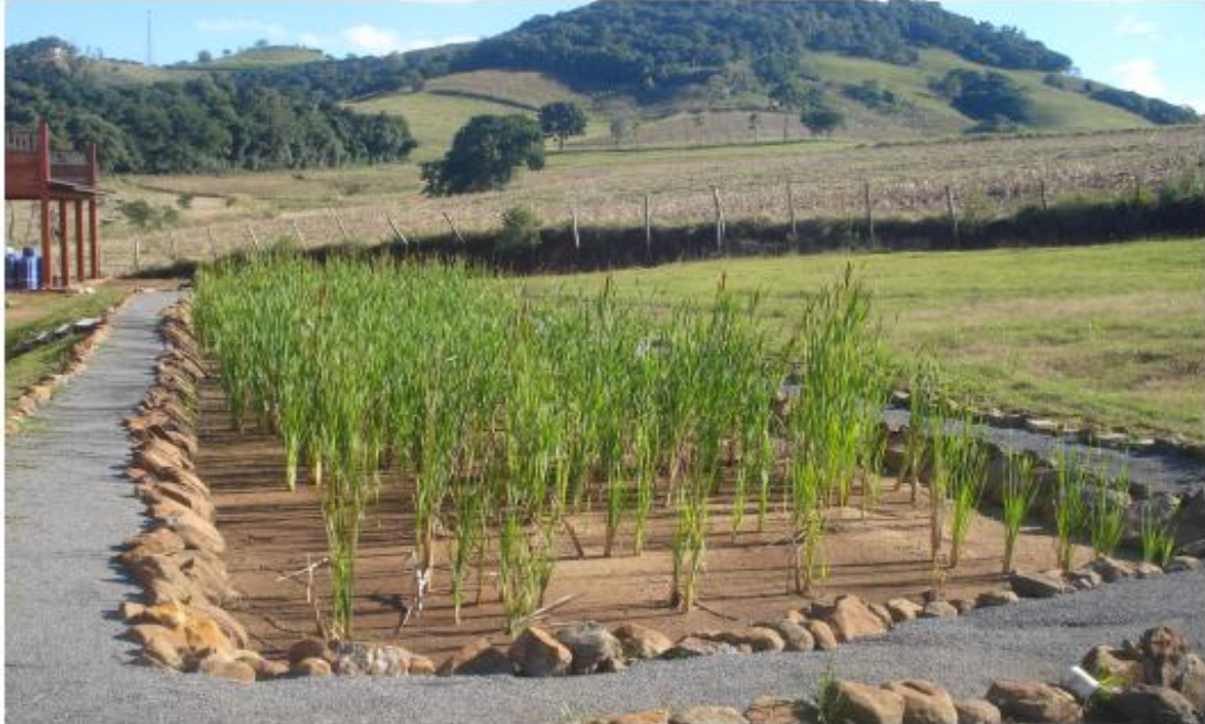
Figura 2: Sistema de tratamento do tipo Wetlands Construídos Horizontal de Fluxo Subsuperficial. (Fonte: GALLINA, 2012).
