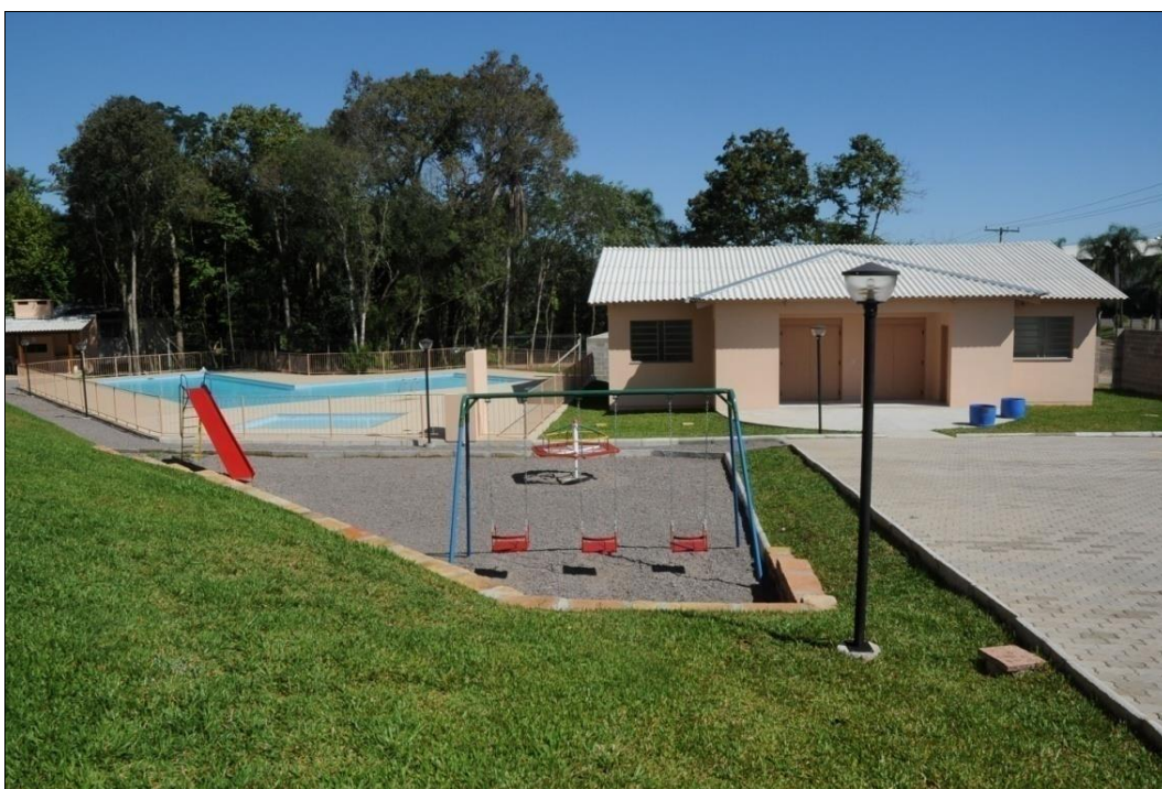
Figura 26 - Área de lazer do Condomínio Residencial Villa Nova
