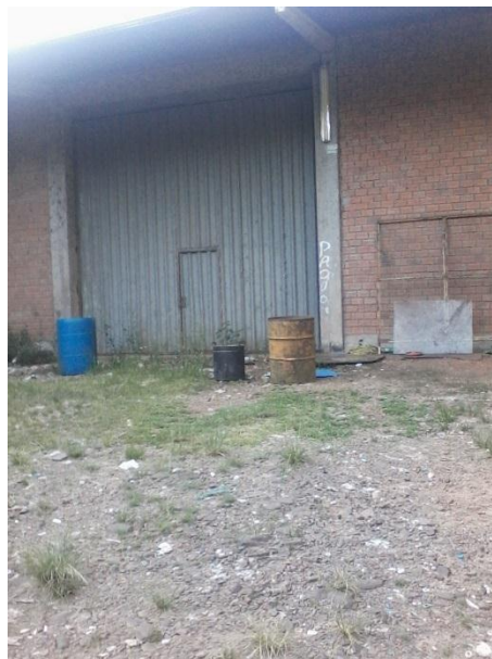
Figura 9 – Galpões no bairro Faxinal, próximo ao Presídio Regional (2)
