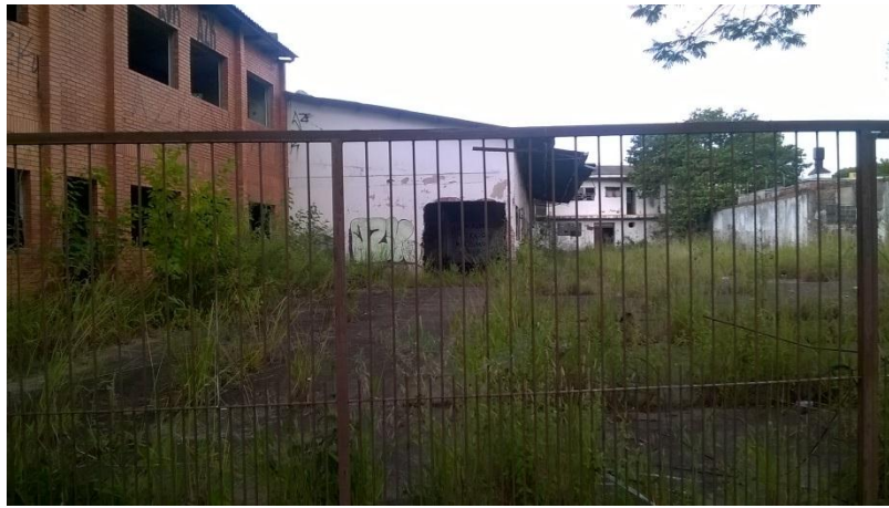
Figura 3 – Prédio abandonado na Avenida Independência
