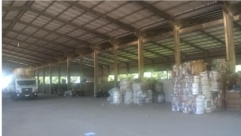
Figura 14 – Entrada do pavilhão de reciclagem
