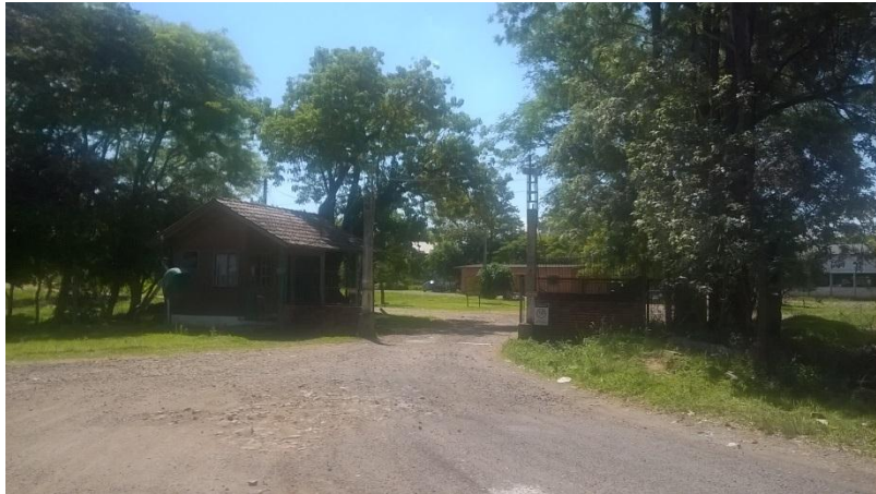
Figura 7 – Usina Municipal de Triagem - UT
