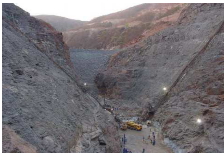
Figura 9 – Usina hidrelétrica de Irapé
