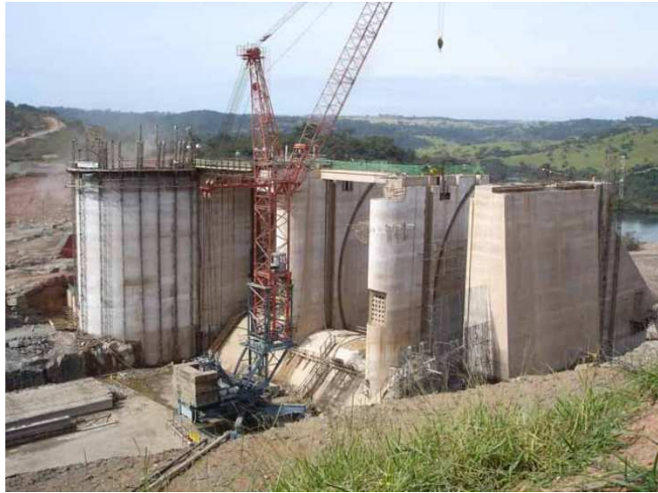
Figura 10 – Usina hidrelétrica de Capim Branco I
