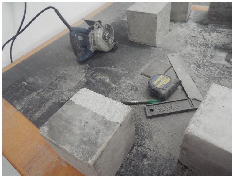
Figura 17 - Preparo das superfícies de concreto
