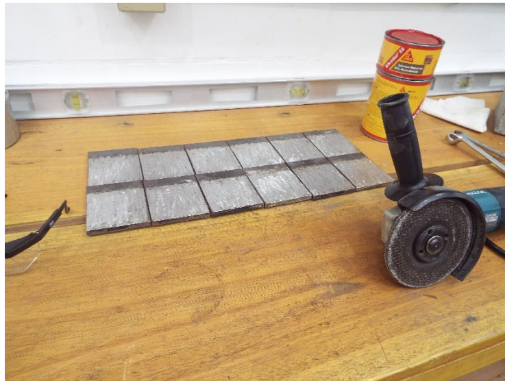
Figura 18 - Preparo das superfícies de aço
