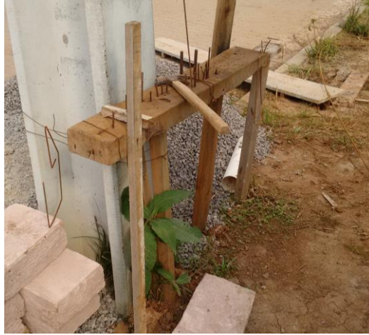
Fotografia 5 – Bancada para dobra de aço amarrada ao poste de energia elétrica
