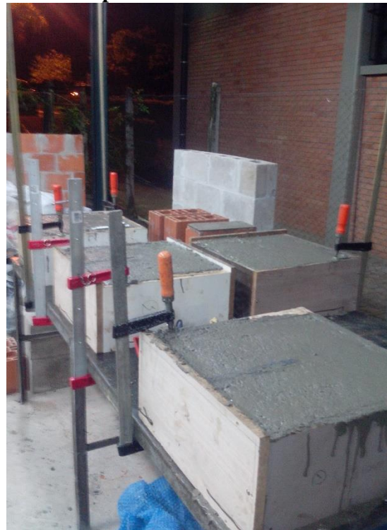
b) consoles nivelados
