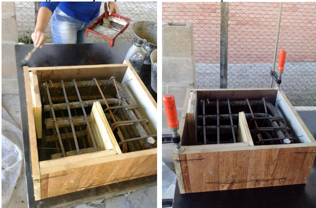
Figura 22 - Aplicação de desmoldante e fixação das formas
