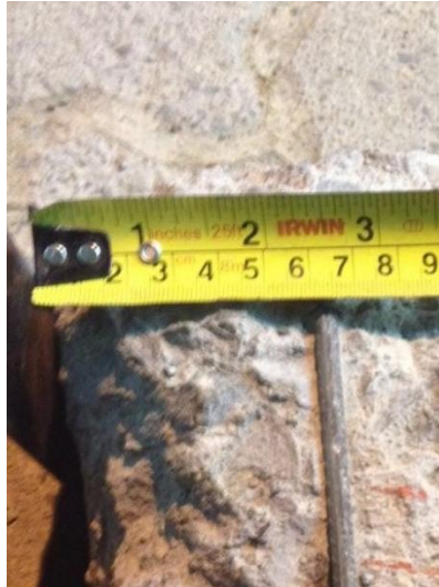
Figura 43 - Verificação do d' para o console 4 =6,5 cm
