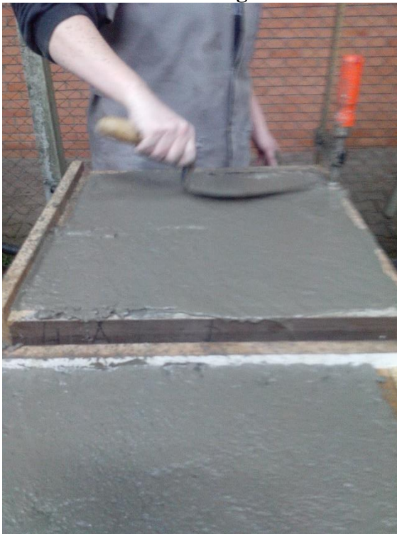
a) execução do nivelamento
