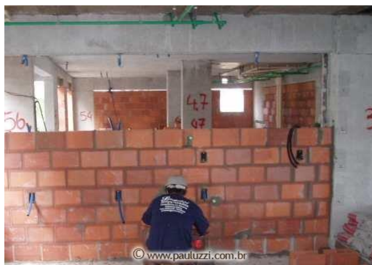
Figura 4 - Exemplo de alvenaria racionalizada
