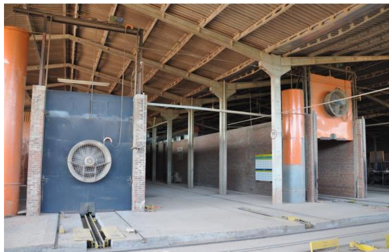
Figura 11 - Vagões de queima de blocos cerâmicos
