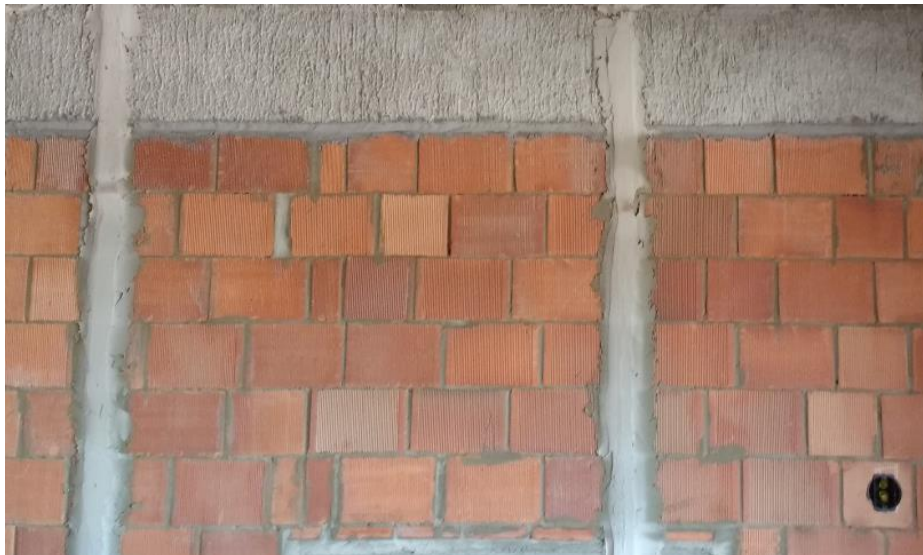
Figura 40 - Encunhamento com argamassa
