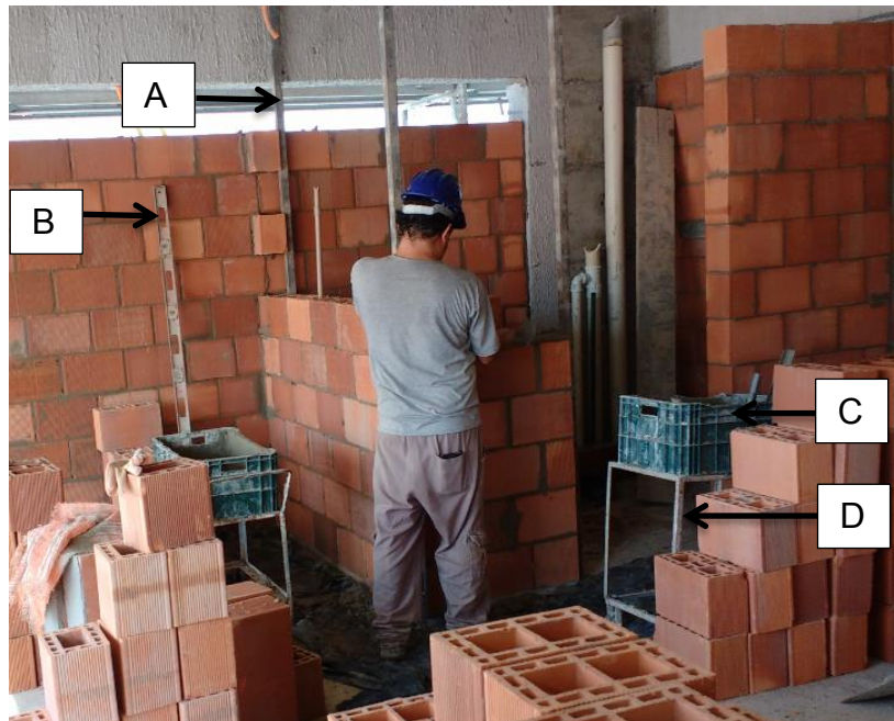
Figura 37 - Ferramentas utilizadas para execução da alvenaria
