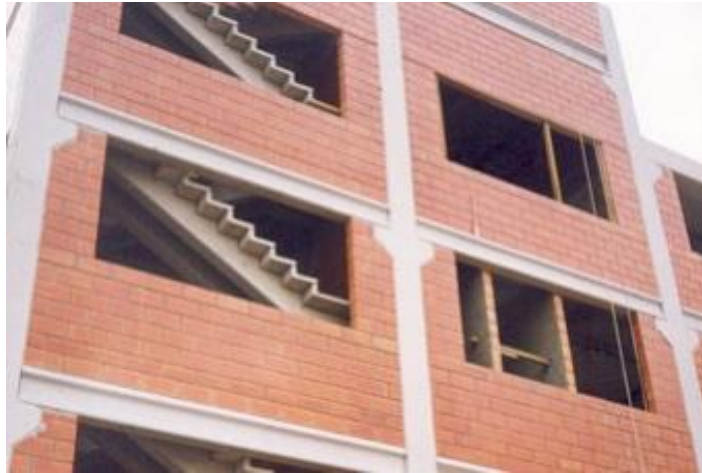
Figura 2 - Alvenaria de Vedação
