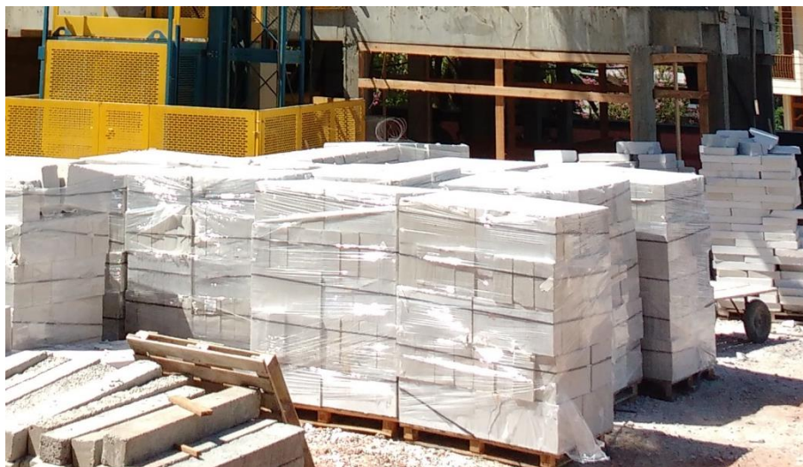
Figura 15 – BCCA armazenados no canteiro de obra
