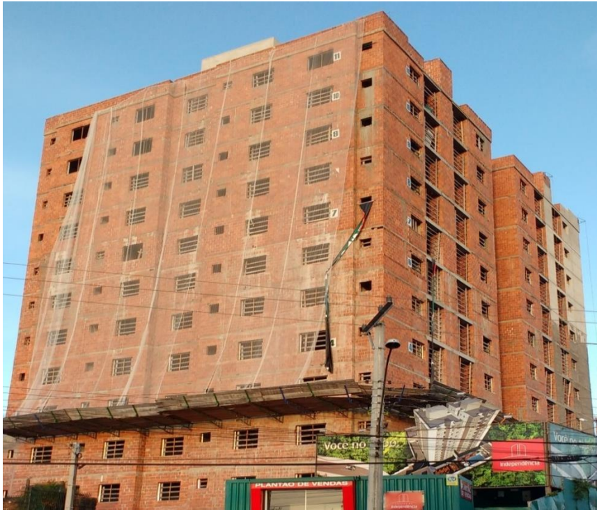
Figura 1- Prédio executado em alvenaria estrutural
