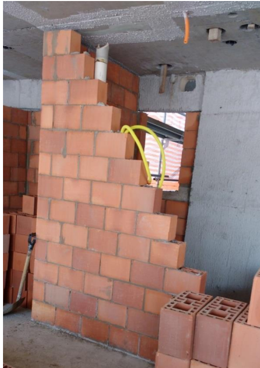
Figura 39 – Amarração dos blocos em formato de castelo
