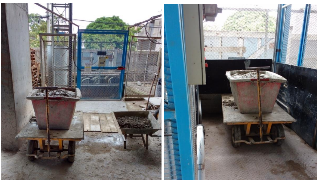
Figura 16 – Transporte de argamassa
