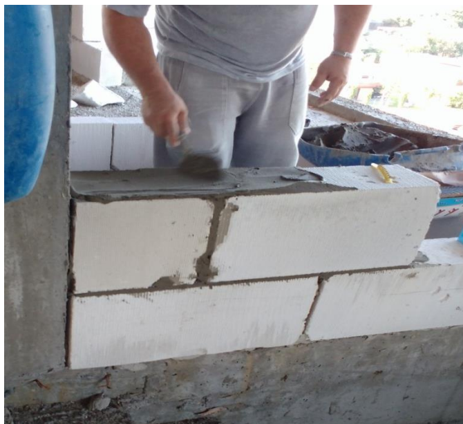
Figura 19 – Preenchimento dos blocos com argamassa
