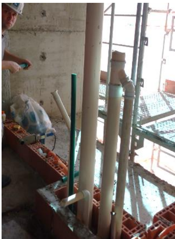
Figura 46 - Utilização de shaft na obra
