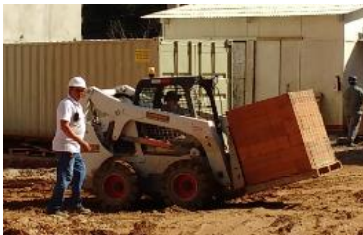
Figura 34 - Carregadeira adaptada para empilhadeira
