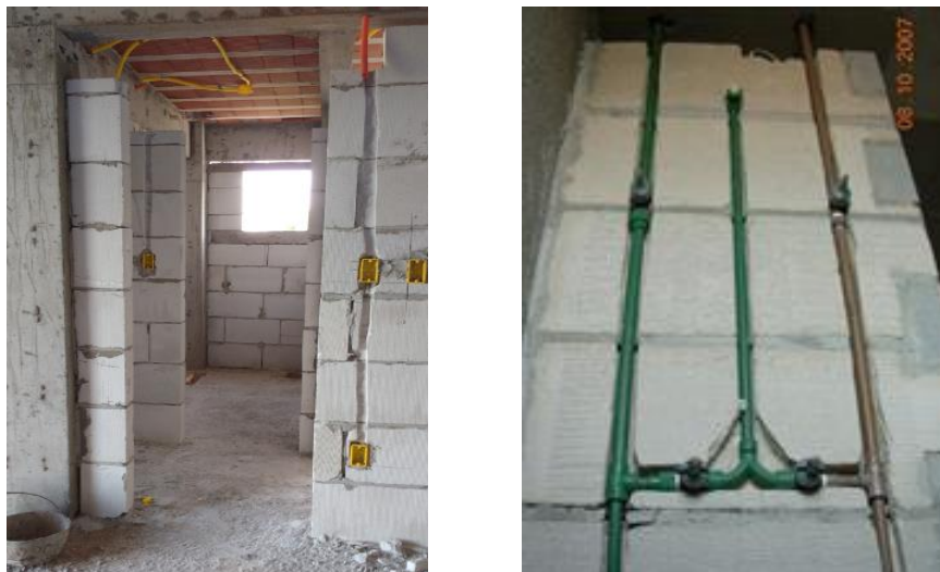
Figura 24 - Alvenaria recebendo instalações elétricas e hidráulicas
