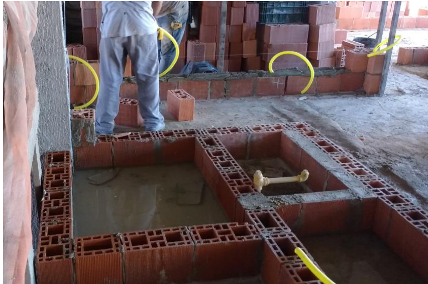
Figura 36 – Marcação da alvenaria interna
