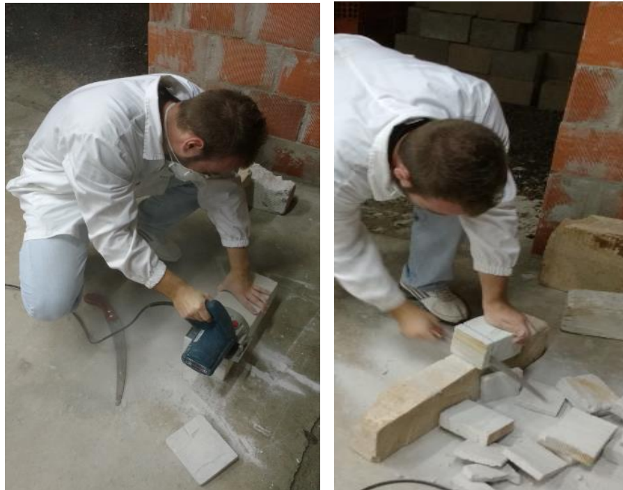
Figura 17 – Corte dos blocos com serra e serrote
