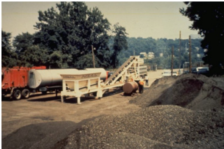
Figura 13 - Processo de reciclagem a frio em usina
