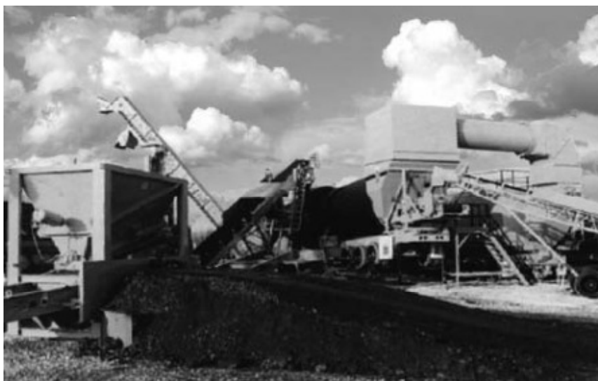
Figura 10 - Usina Drum-Mix em processo de reciclagem de RAR
