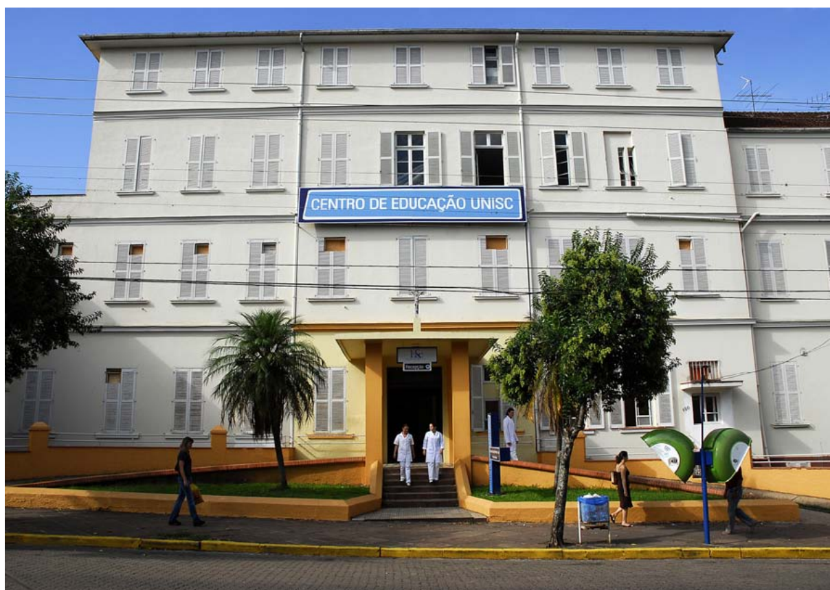
Novas instalações Hospital Santa Cruz.
