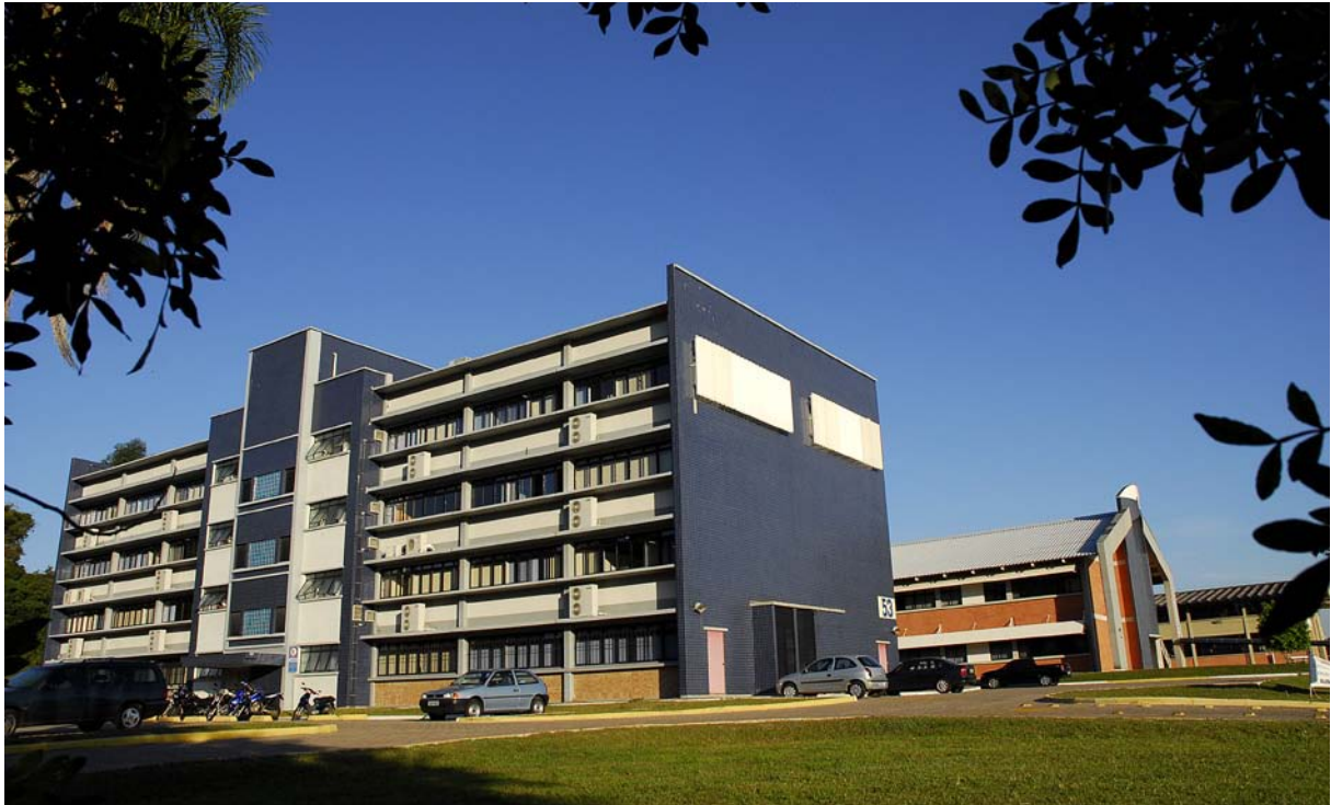
Bloco 53 salas de aula.
