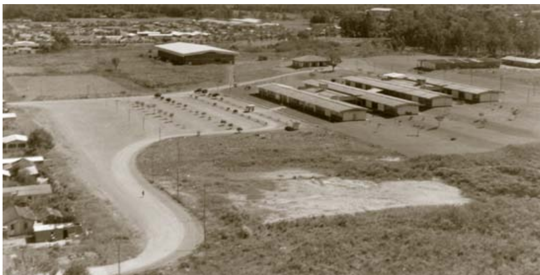
O acesso ao campus era feito somente pelo sul, em 1991.
