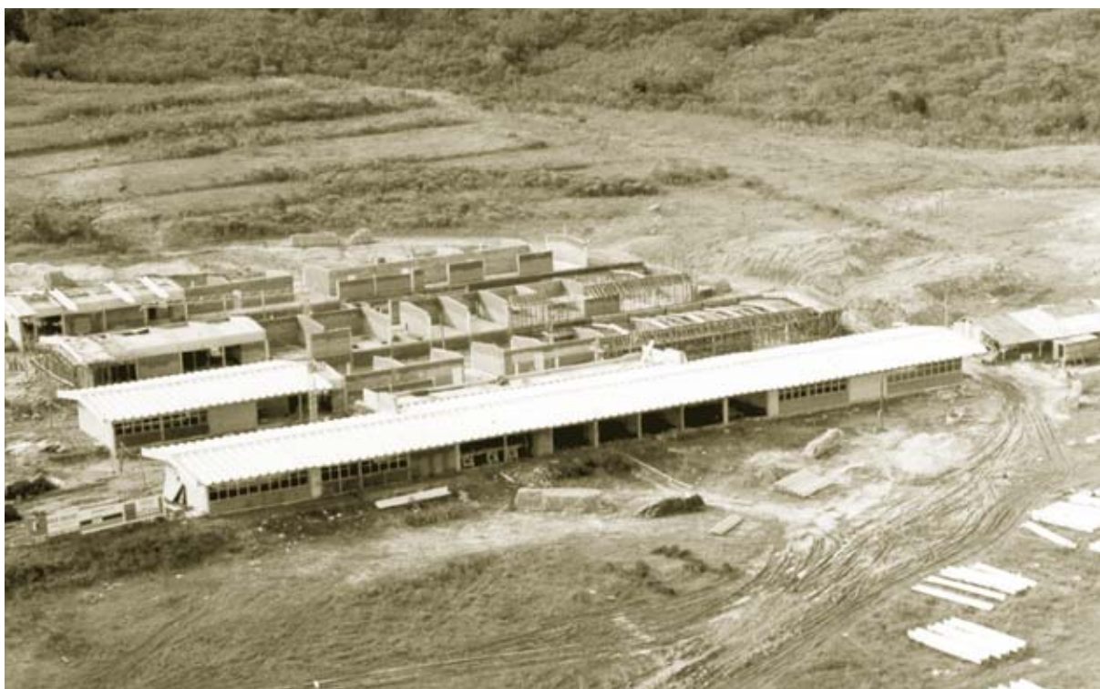
Em 1983, obras dos primeiros blocos no Campus.
