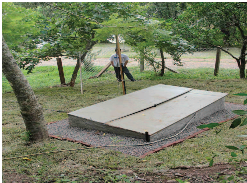
Figura 4 — Nascente depois das benfeitorias e instalação das leivas de grama
