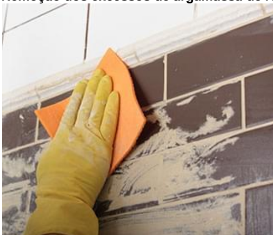
Figura 17 - Remoção dos excessos de argamassa de rejuntamento
