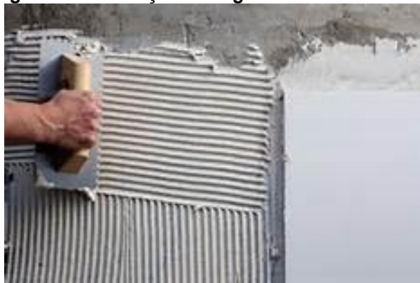
Figura 14 - Execução de Argamassa Colante
