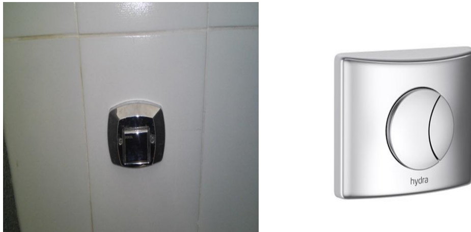
Figura 7: Acabamento simples 9 litros e Acabamento de 3/6 litros
