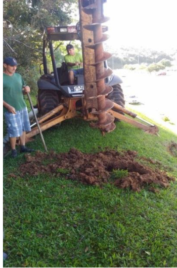
Figura 17 – Broca que realizou a sondagem mecânica.
