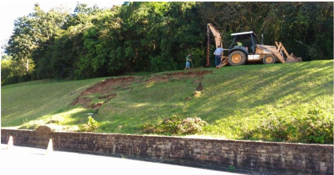
Figura 16- Conjunto moto-mecanizado realizando a sondagem
