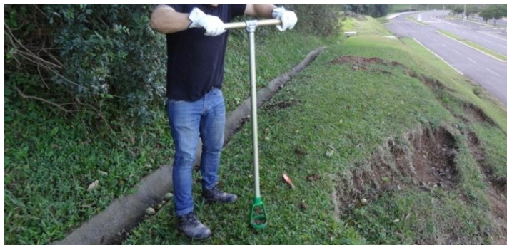
Figura 15 – Realização dos furos de sondagem através do trado manual
