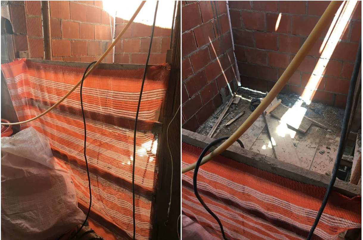
Figura 22 - Poço do elevador
