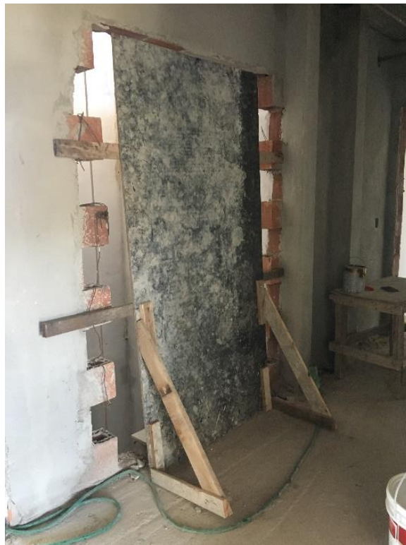
Figura 7 - Fechamento poço do elevador
