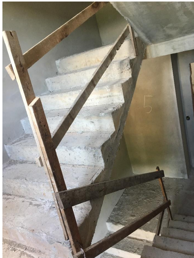
Figura 5 - Corrimão provisório
