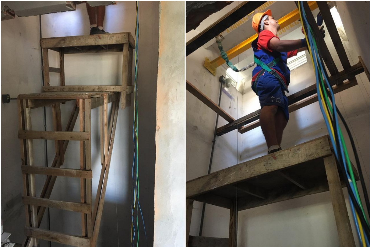
Figura 8 - Execução de serviço no poço do elevador
