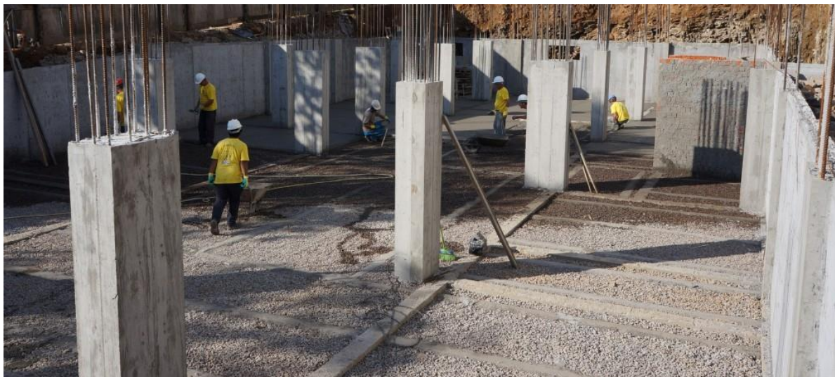
Figura 6 - Cortina de contenção em concreto armado moldada no local
