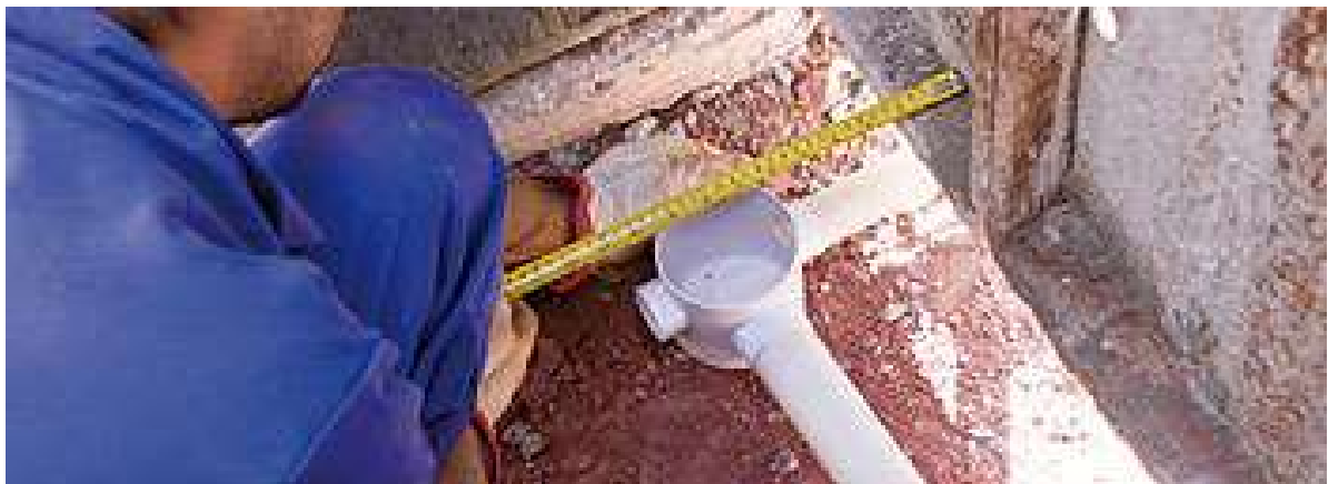
Figura 12 – Tubulação de esgoto locada antes da concretagem do piso ou fundação
