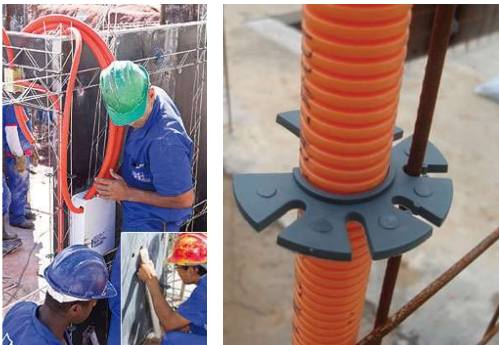
Figura 13 – Instalação de caixa de passagem na fôrma e espaçador plástico
