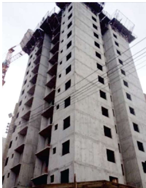
Figura 1 – Exemplo de edifício de paredes de concreto moldado “in loco”
