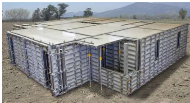
Figura 2 – Fôrmas metálicas aplicadas em obra
