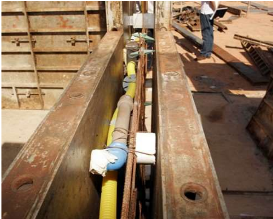
Figura 11 – Instalações hidráulicas amarradas e espaçadas dentro da fôrma
