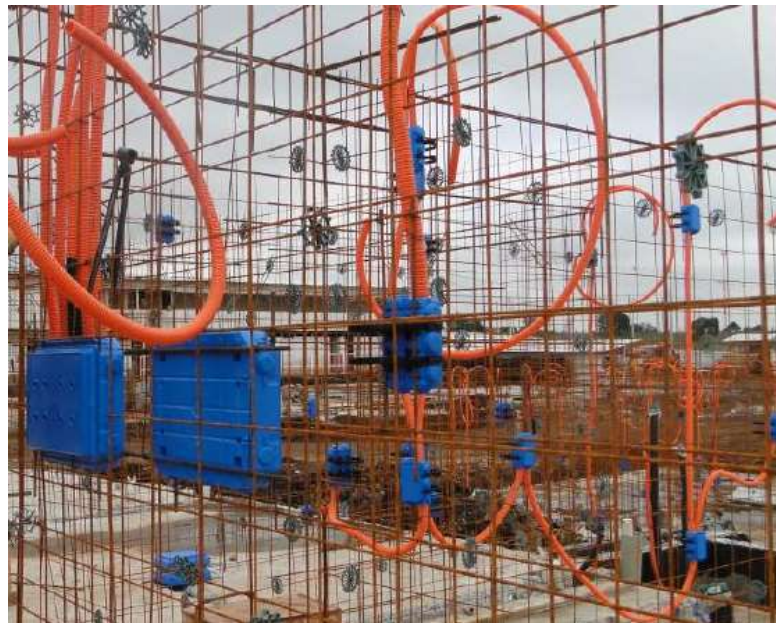
Figura 15 – Instalações elétricas amarradas nas armaduras
