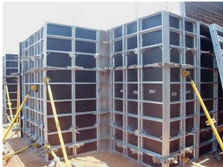
Figura 5 – Fôrmas metálicas + compensadas
