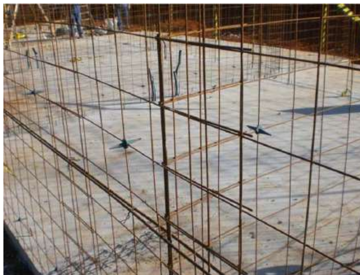
Figura 8 – Telas soldadas de aço locadas em obra
