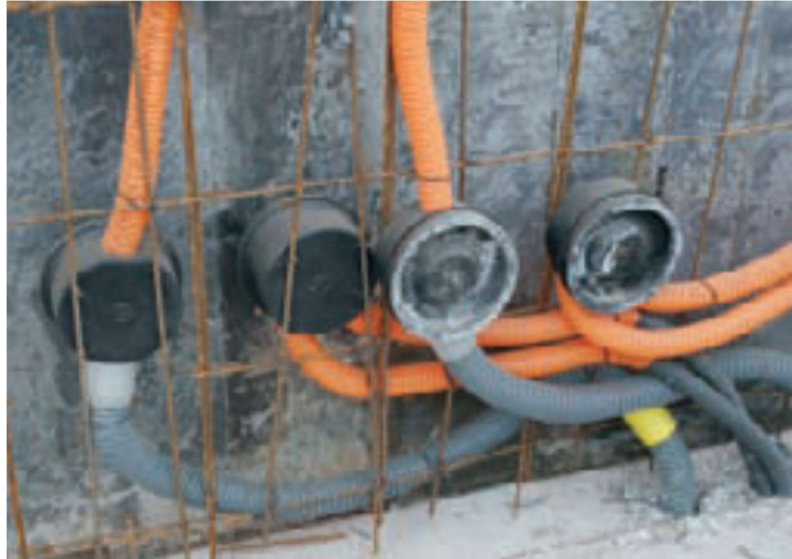
Figura 14 – Posicionamento das tomadas na fôrma
