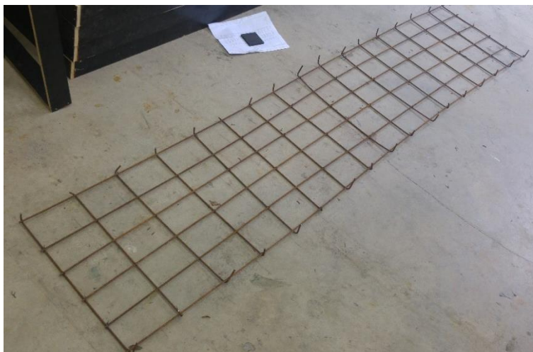
Figura 12 - Armadura montada sobre o gabarito
