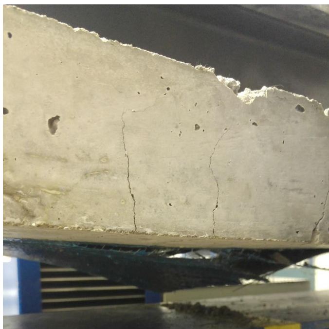
Figura 27 - Fissuras de flexão na face lateral da laje
