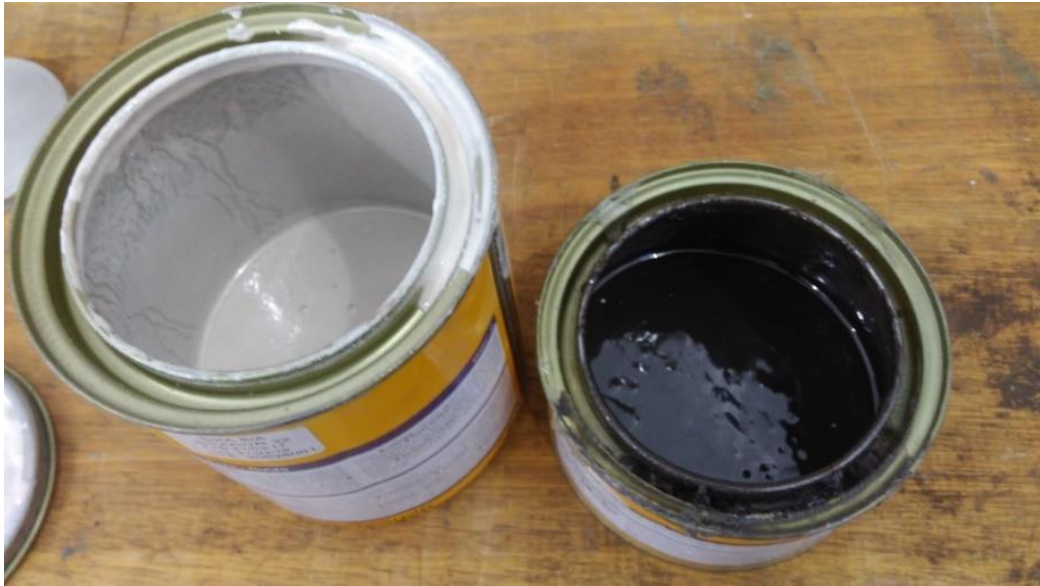
Figura 49 - Preparação da resina epóxi
