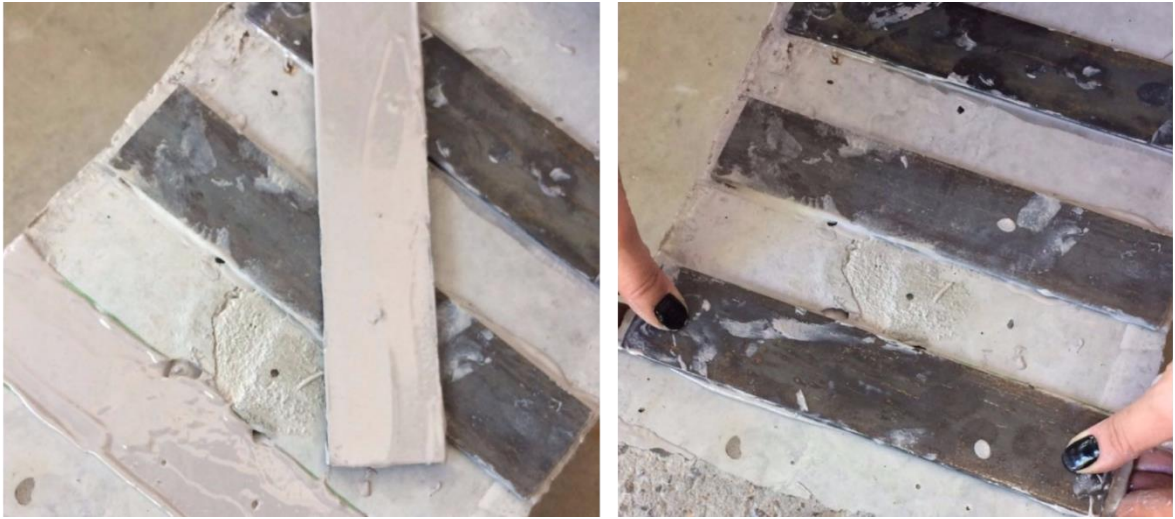
Figura 50 - Colagem das chapas metálicas
