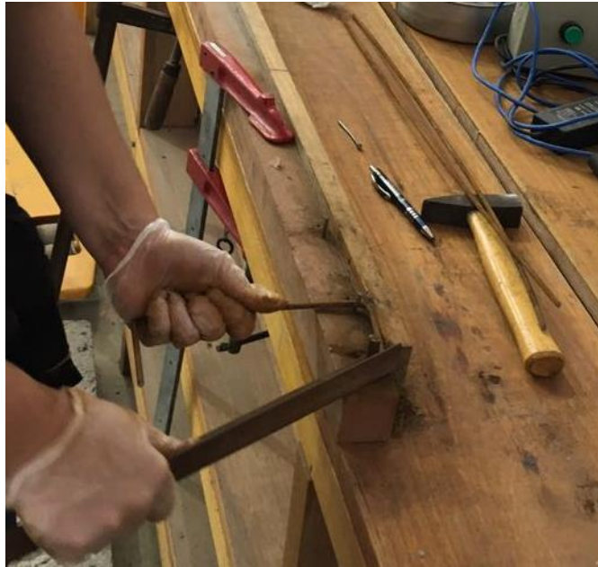
Figura 40 – Processo de dobra dos estribos
