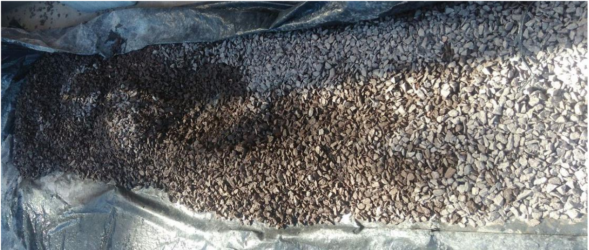
Figura 43 - Preparação do agregado graúdo
