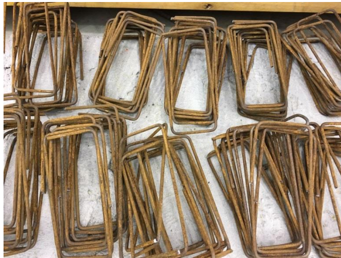
Figura 41 - Armadura transversal pronta
