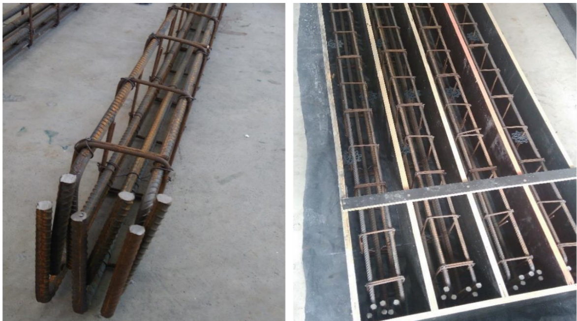
Figura 42 - Armadura completa
