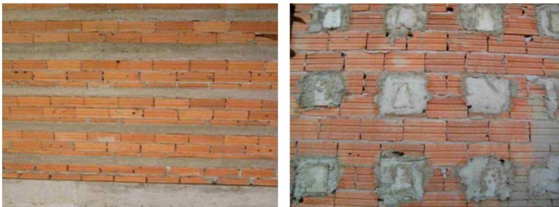
Figura 7 – Elementos de concreto em meio à alvenaria
