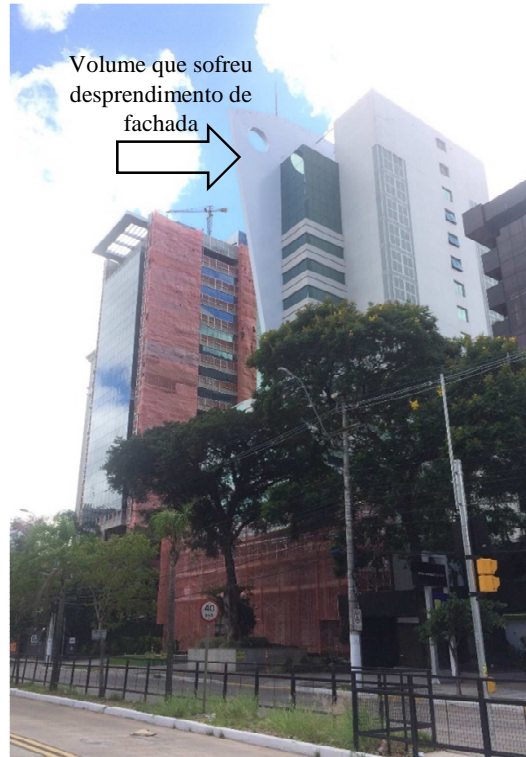
Figura 35 – Edifício Trust Business Center (direita) ao lado do Edifício Capital Tower
