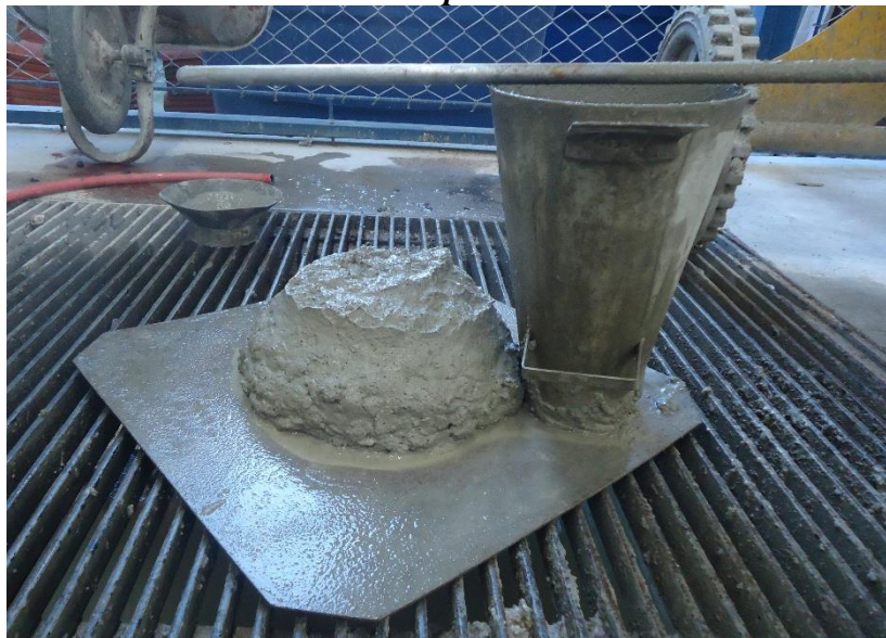
Figura 13 – Verificação do abatimento pelo ensaio de abatimento de tronco de cone “ slump test ”.
