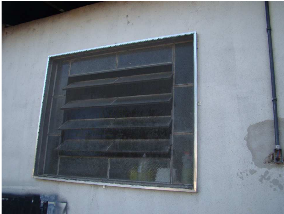
Figura 22: Detalhe de abertura abrigo externo com proteção contra insetos no H1
