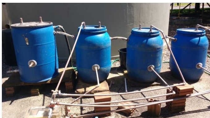
Figura 9 - Tanque decantador (esquerda) seguido de três tanques anaeróbicos em paralelo.
