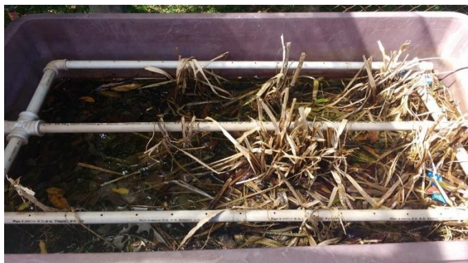
Figura 10 - Garfo distribuidor do WC.
