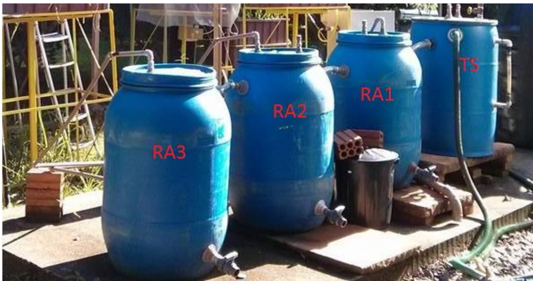
Figura 17 - Registro fotográfico dos reatores anaeróbios..
