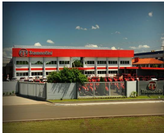
Imagem 4 - Instalação da empresa em Venâncio Aires após reforma
