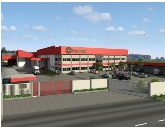
Imagem 3 - Instalação da empresa em Venâncio Aires após reforma
