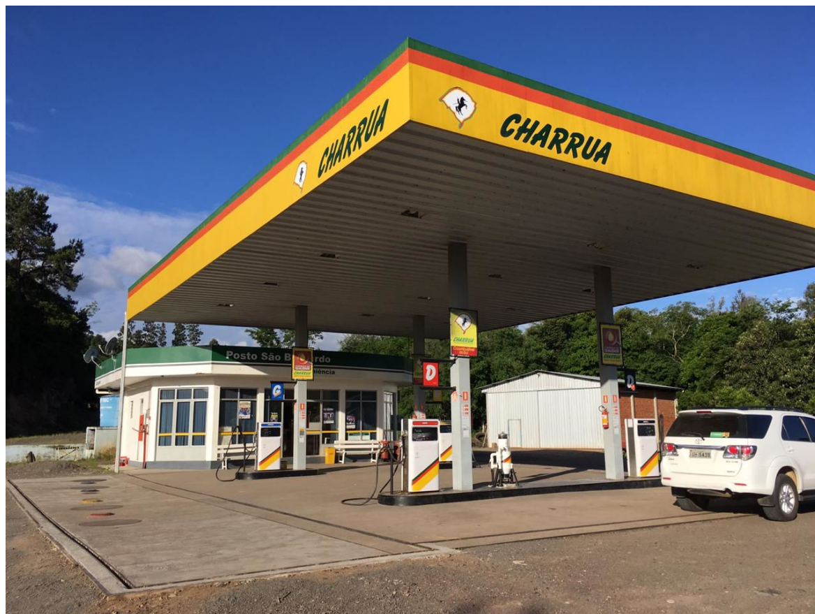
Foto 3: Imagem do Posto após tornado- reconstrução.
