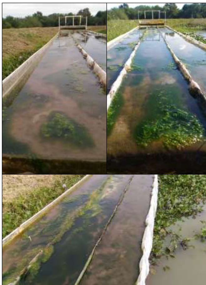
Figura 8 - Manchas sem formação de perífíton observadas no sistema ATS ® , devido ao acúmulo de material particulado existente na água bruta do lago.
