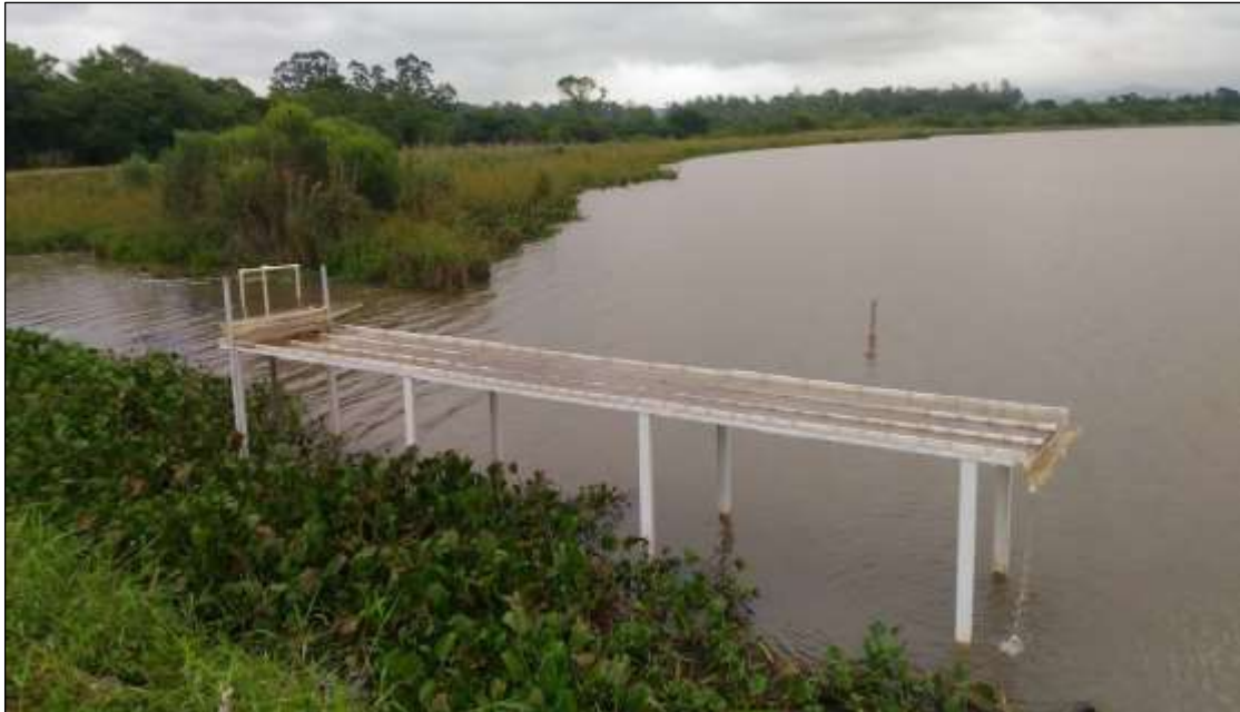
Figura 4 - Unidade piloto ATS® instalada junto ao reservatório de abastecimento de água de Santa Cruz do Sul.
