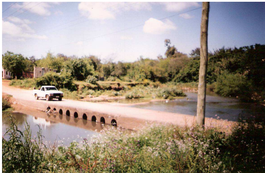
FIGURA 18 – Ponte do Passo do Onze
