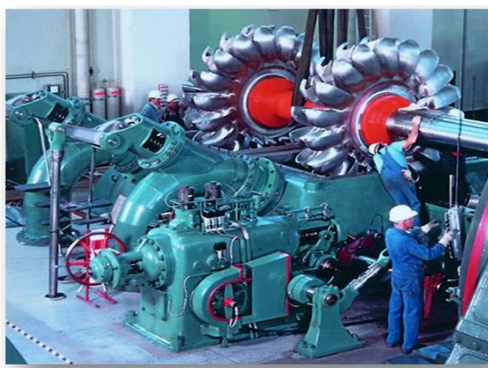
Figura 12 - Turbina Pelton em operação
