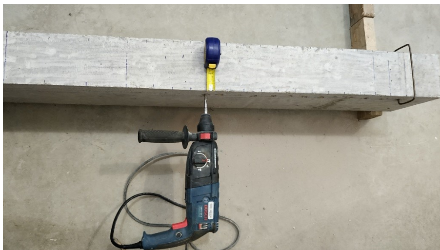
Figura 35 – Furação e colocação dos estribos.
