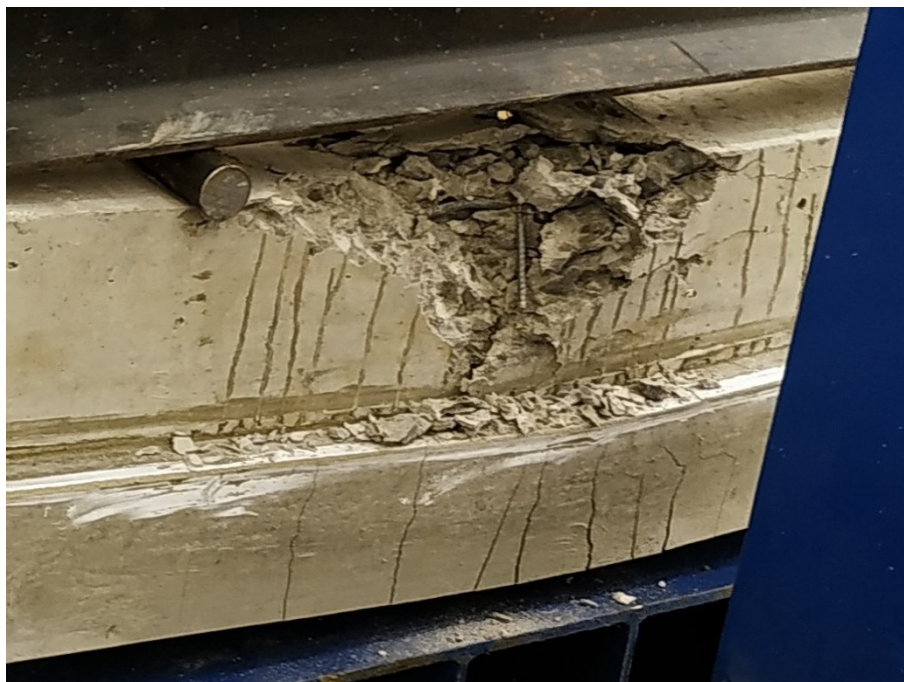
Figura 57 – Detalhe do rompimento viga 3 reforçada.
