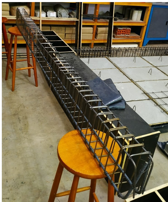
Figura 25 – Armadura principal das vigas pronta.
