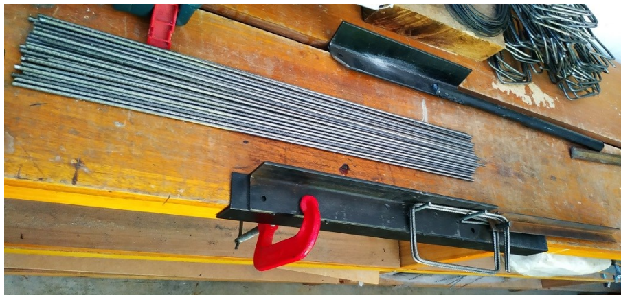
Figura 24 – Estribos 5 mm das vigas.
