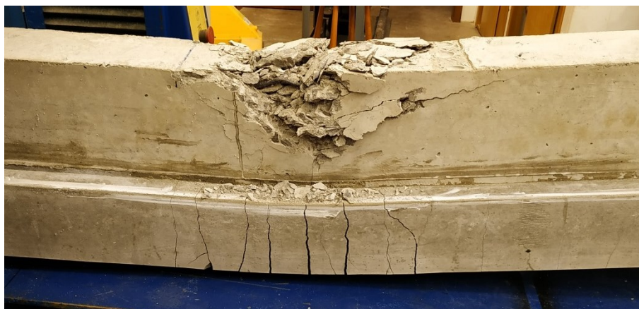
Figura 55 – Detalhe do rompimento viga 2 reforçada.
