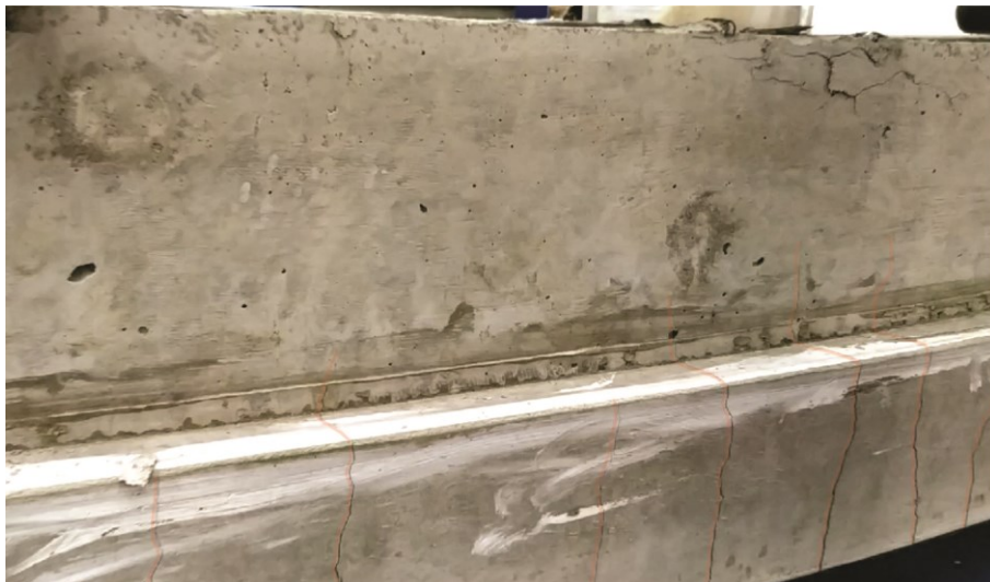
Figura 53 – Detalhes do rompimento viga 1 reforçada.
