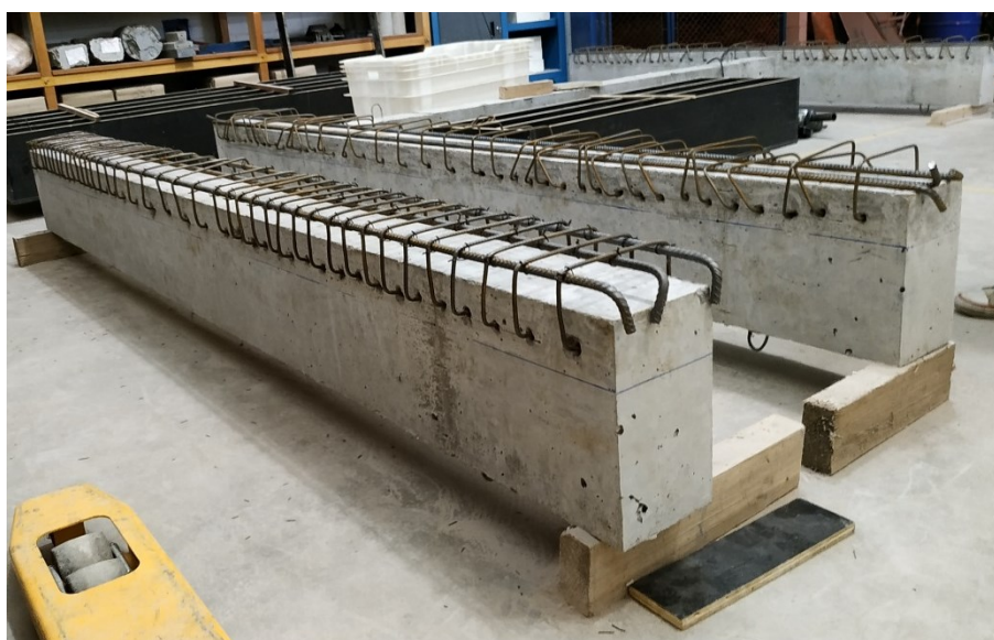
Figura 36 – Armadura de reforço das vigas pronta.
