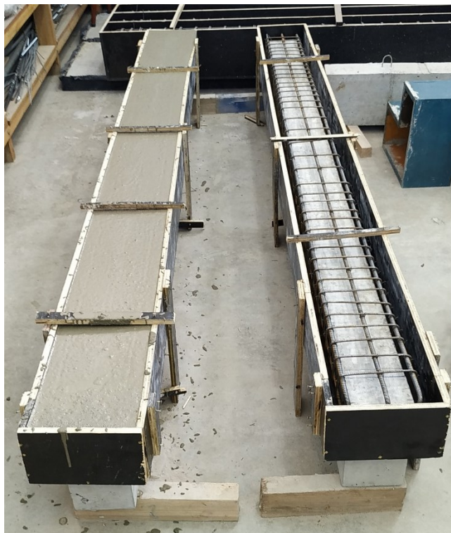
Figura 40 – Grauteamento do reforço.
