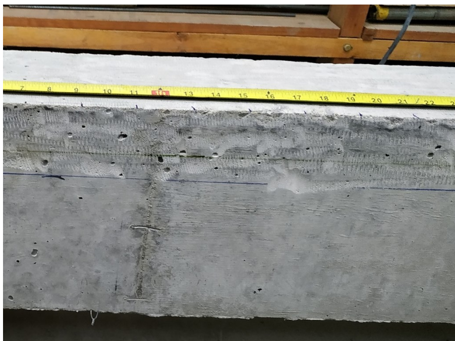
Figura 34 – Marcação e escareamento.
