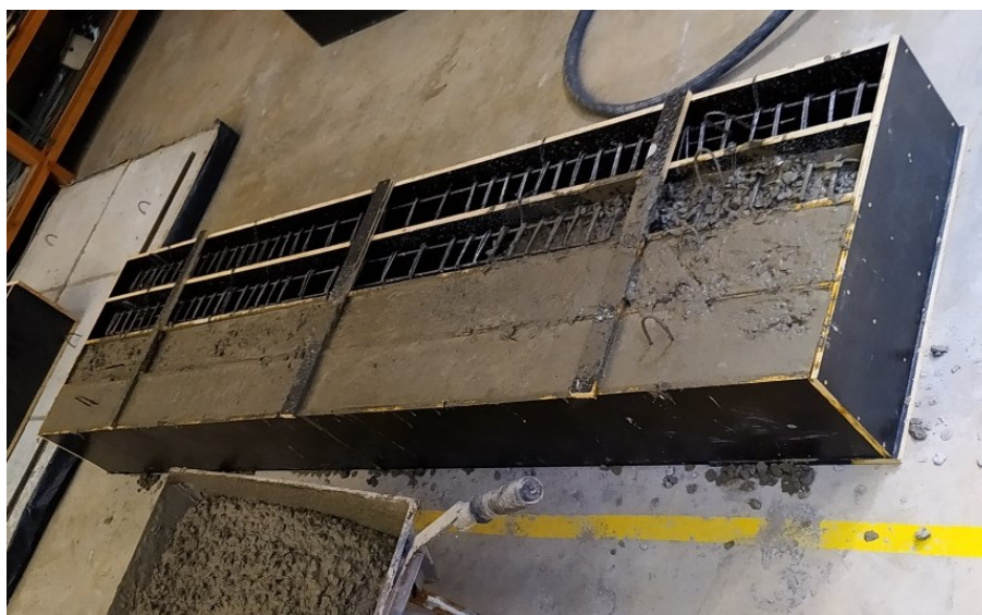
Figura 29 – Concretagem das vigas.
