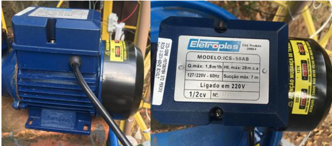
Figura 8 – Motobomba hidráulica para bombeamento do efluente até a primeira caixa do sistema.
