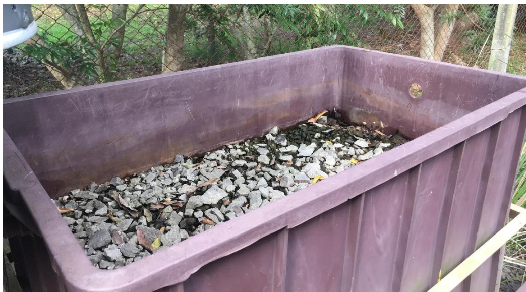
Figura 6 – Caixa destinada ao tratamento com filtro de areia.
