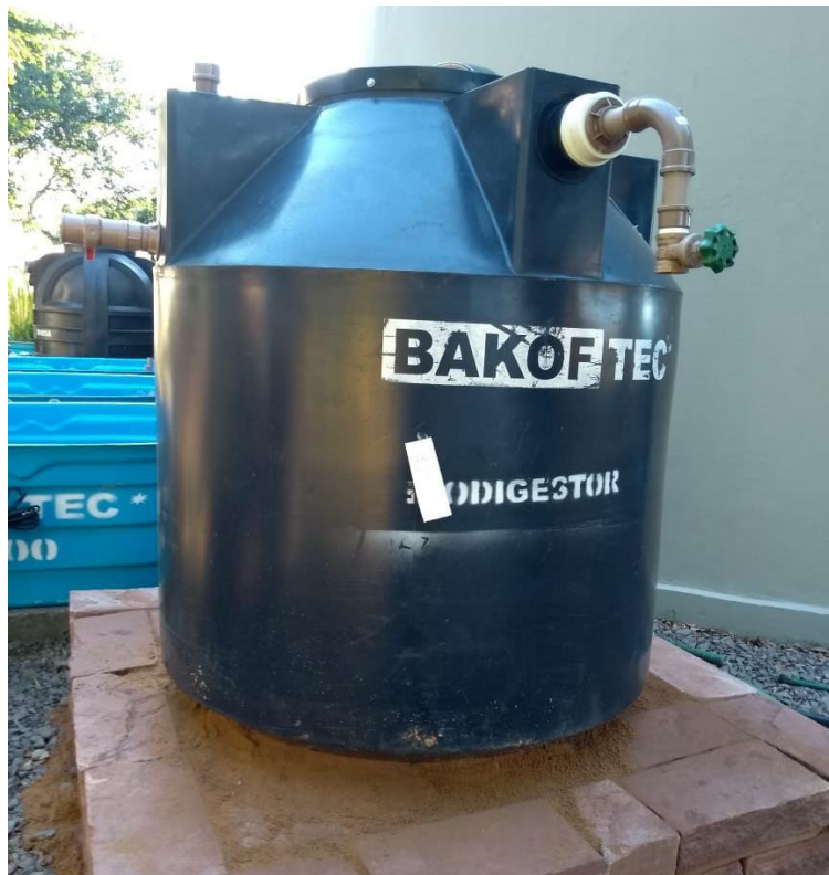
Figura 3 – Reator anaeróbio utilizado para o tratamento secundário de efluente.
