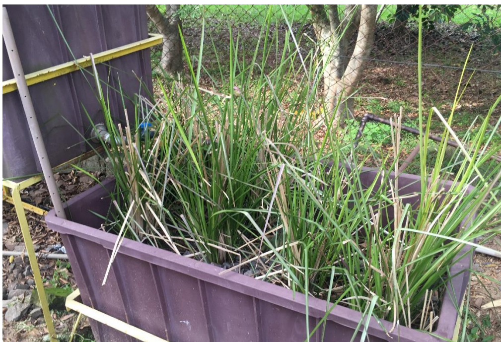
Figura 7 – Sistema de Wetland Construído com a macrófita Chrysopogon zizanioides .
